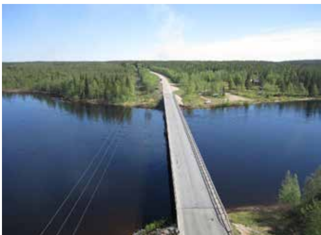
Figur 2.4 -1 Vybild över Tarendö älv, Vattenfalls ledning syns till vänster.
