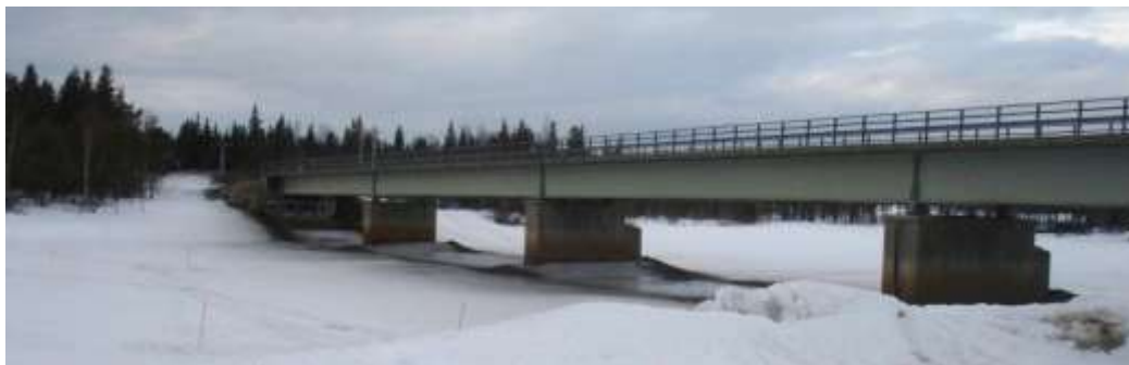
Befintlig bro över älven.
