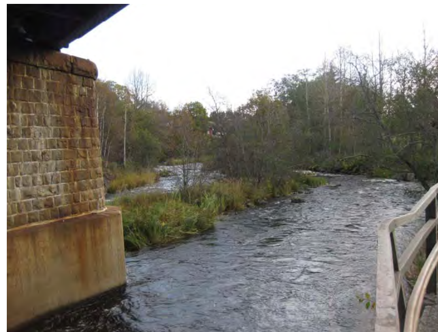
Figur 5.8. Gådeån vid Gådeå by. Till vänster syns fundamenten till den befintliga järnvägsbron.
