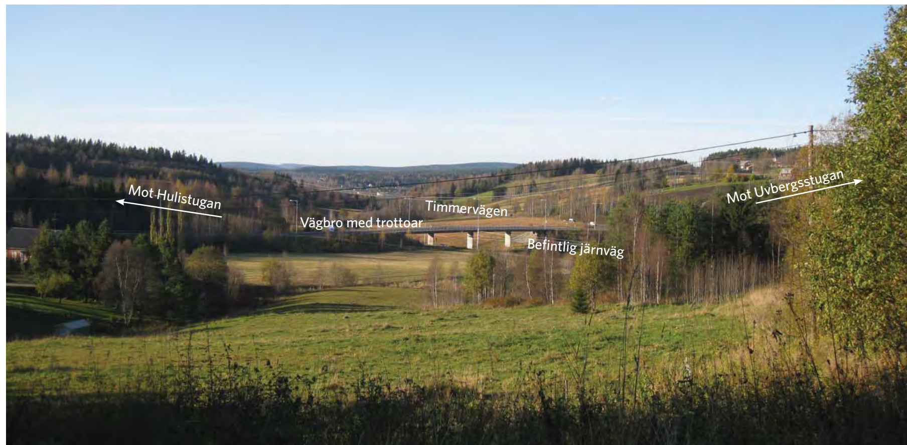
Figur 8.5.2 Bro över befintlig järnväg i Huli. Bron förbinder spårssystem kring Hulistugan med spåren kring Uvbergsstugan.
