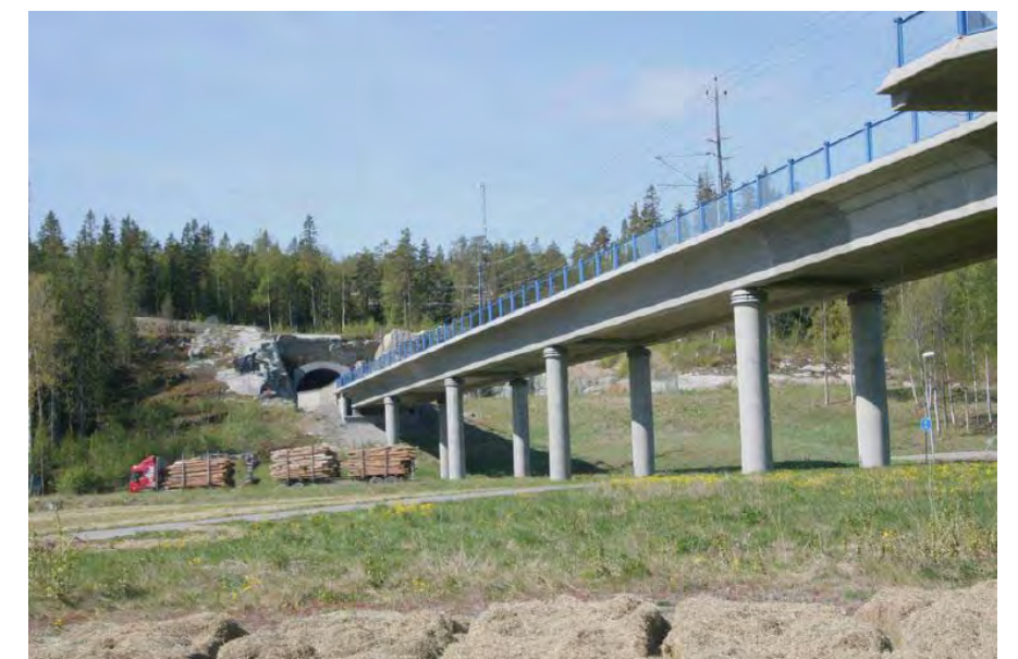
Figur 4.5.5 Exempel på betongbro.
