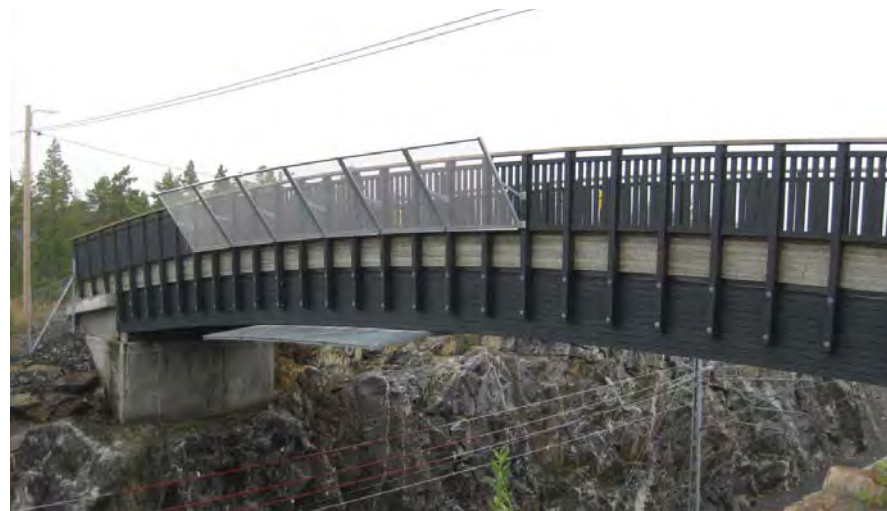
Figur 5.2.7 Hög estetisk bearbetningsgrad vad gäller gångbros/skidbros utformning, material och ytskikt.
