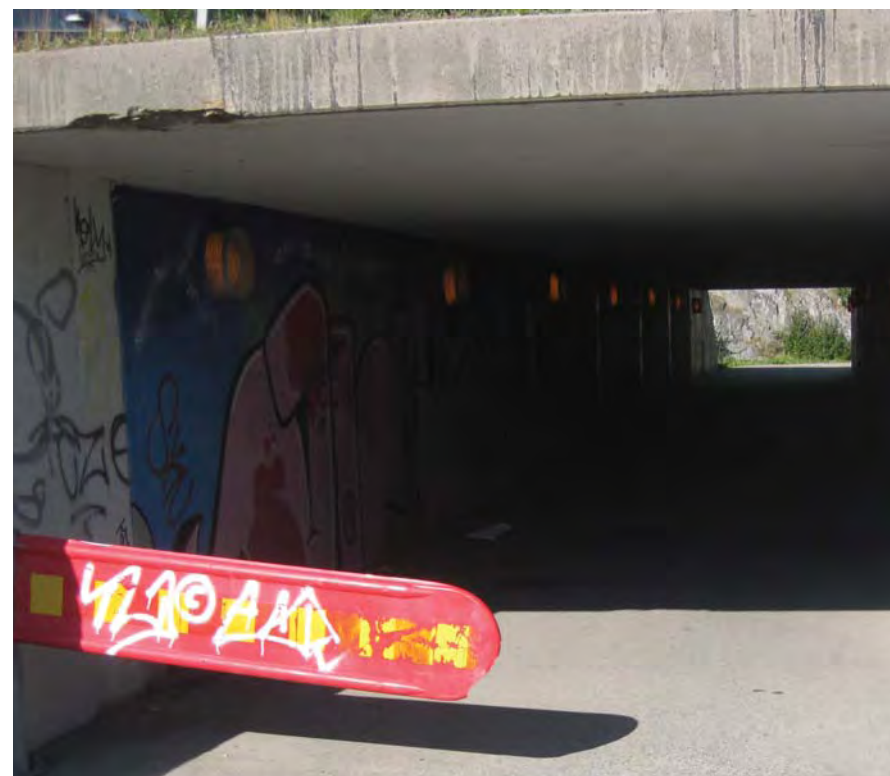
Figur 8.6.1 Långa gångtunnlar upplevs ofta som otrygga platser. Den här tunneln är 30 meter lång och går under E4 vid busshållplatsen i centrala Timrå.
