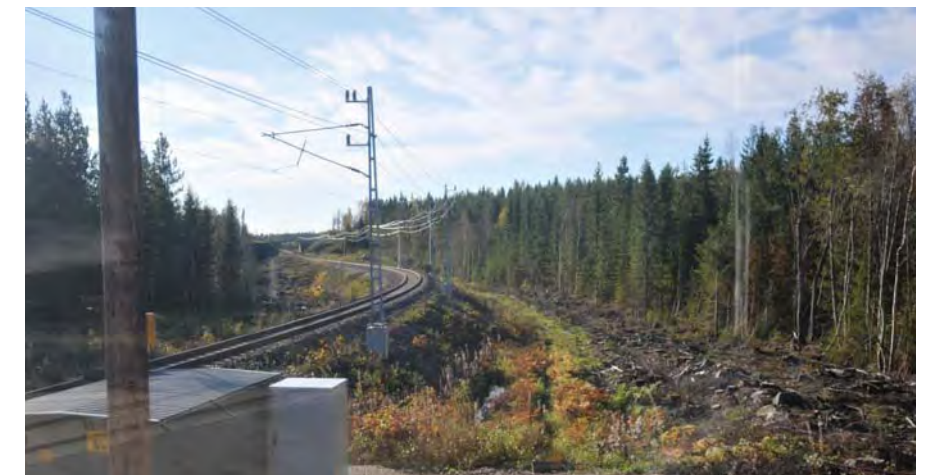
Figur 5.2.2 Järnvägen passerar skogslandskapet. Järnvägsbankarna är branta för att bevara mark. Låg estetisk bearbetningsgrad.
