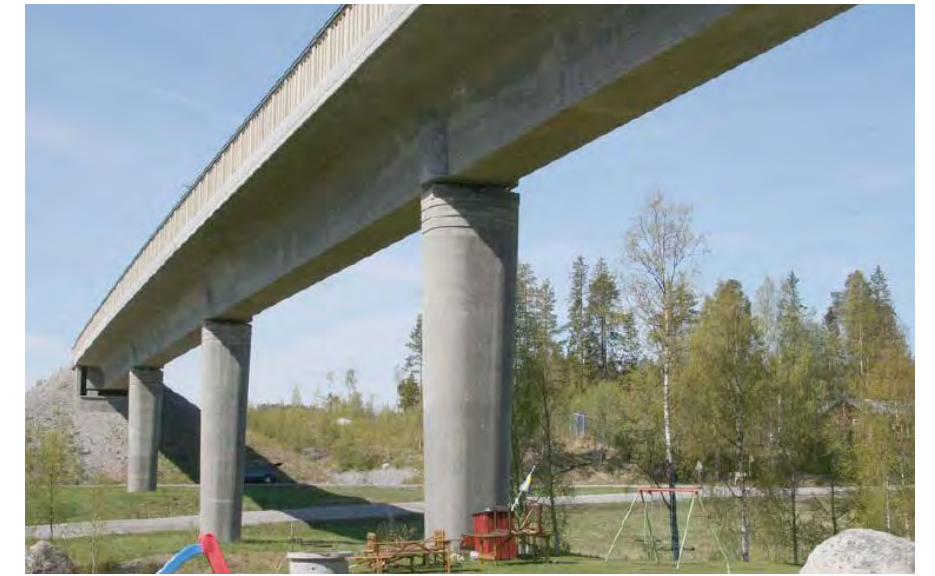
Figur 4.5.4 Exempel på betongbro.
