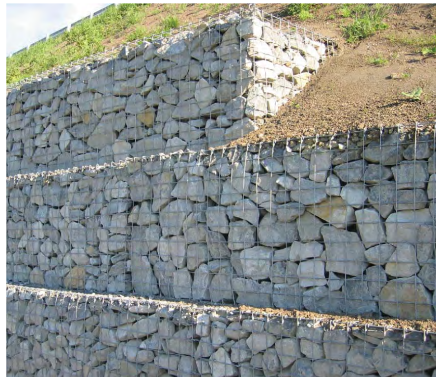
Figur 5.2.15 Exempel på gabionmur.
