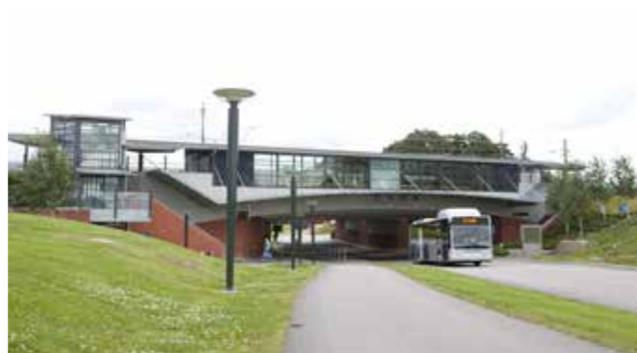
Figur 5.2.9 Falkenbergs station. Hög estetisk bearbetningsgrad vad gäller stationsbyggnad och vägport.
