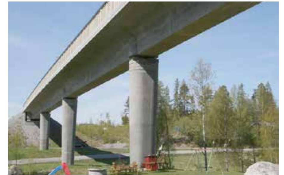
Figur 4.5.4 Exempel på betongbro.
