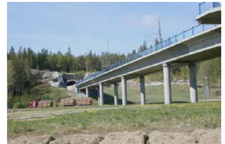
Figur 4.5.5 Exempel på betongbro.
