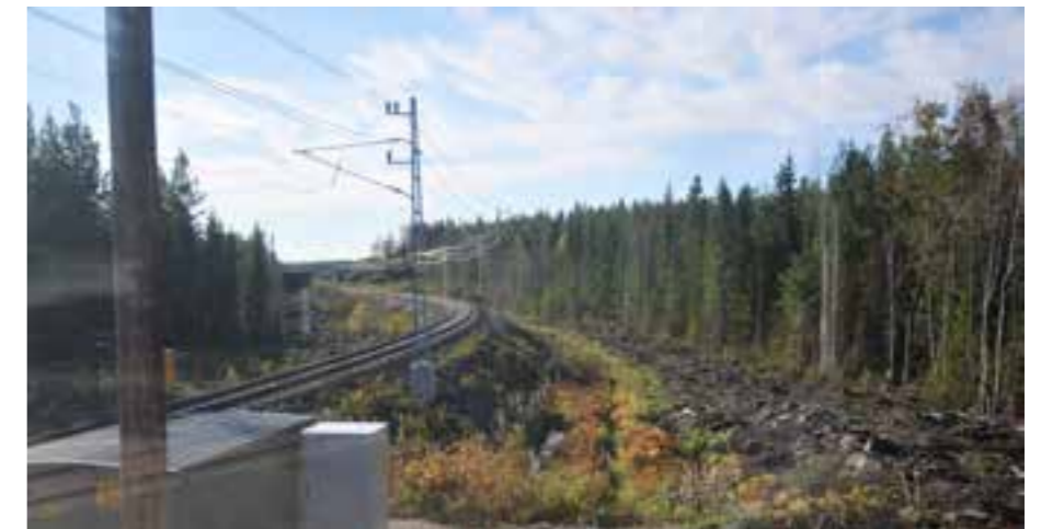
Figur 5.2.2 Järnvägen passerar skogslandskapet. Järnvägsbankarna är branta för att bevara mark. Låg estetisk bearbetningsgrad.
