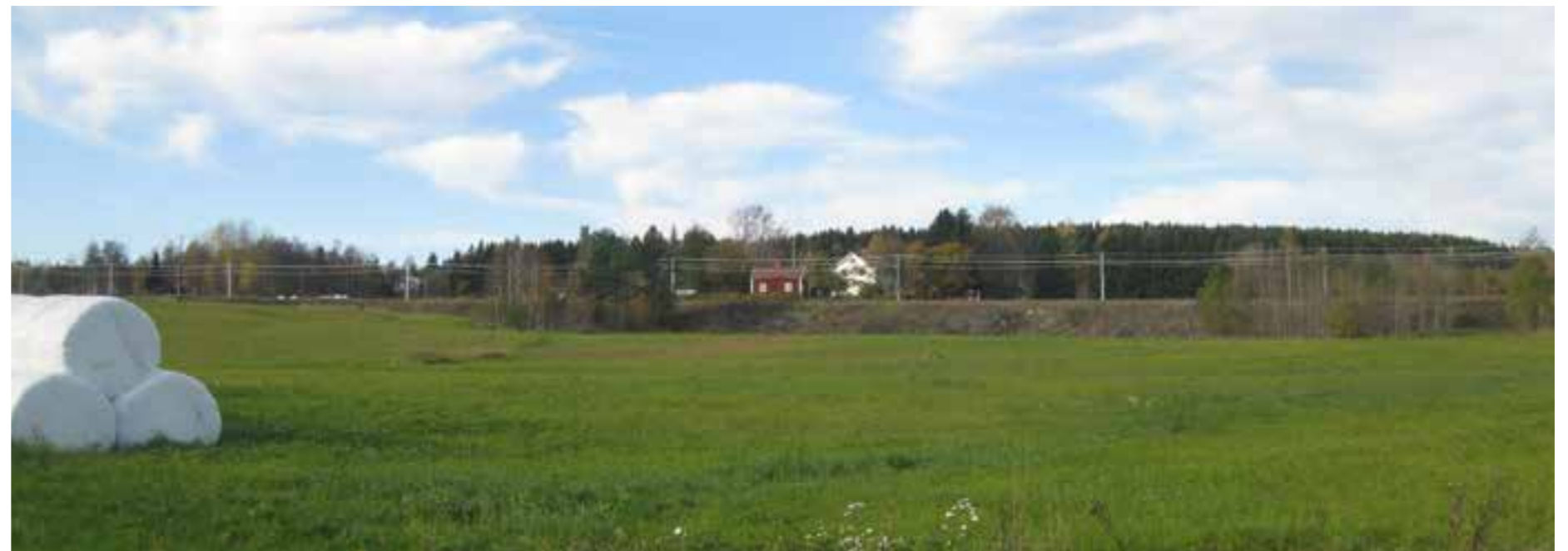
Figur 3.6.5 Järnvägsbank genom odlingslandskapet som utgör en barriär för de boende på vardera sidan av järnvägen, både visuellt och för rörelsen i området.
