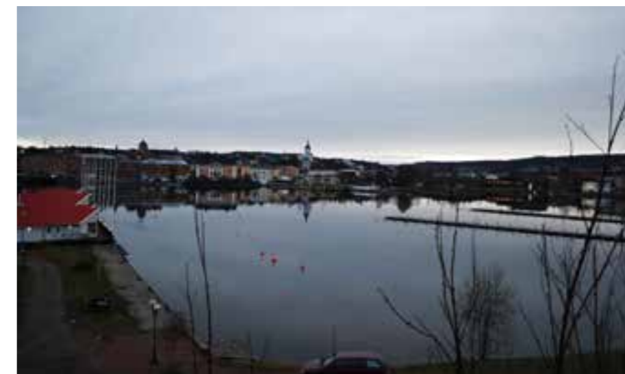
Figur 3.5.14 Härnösands stadssilhuett med domkyrkan och gamla posten som landmärken i stadslandskapet. Vid vattnet ligger det orangefärgade stenhuset som är landshövdingens residens och i förgrunden syns småbåtshamnen som är fylld sommartid. Karaktärsområde 10.
