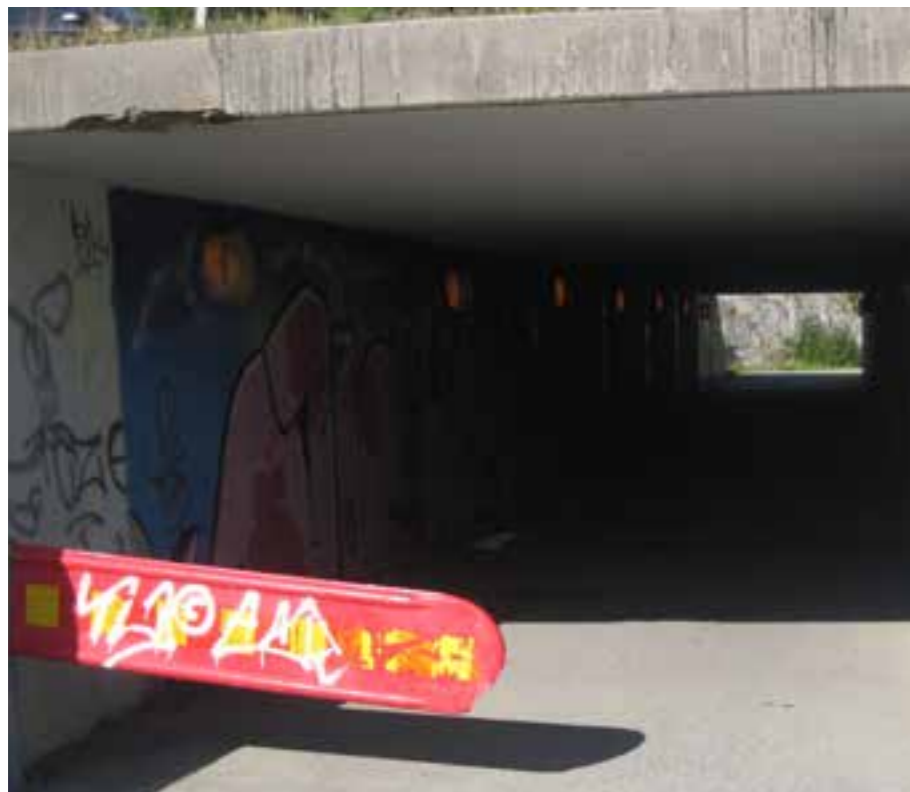
Figur 8.6.2 Långa gångtunnlar upplevs ofta som otrygga platser. Den här tunneln är 30 meter lång och går under E4 vid busshållplatsen i centrala Timrå i Blå korridor.
