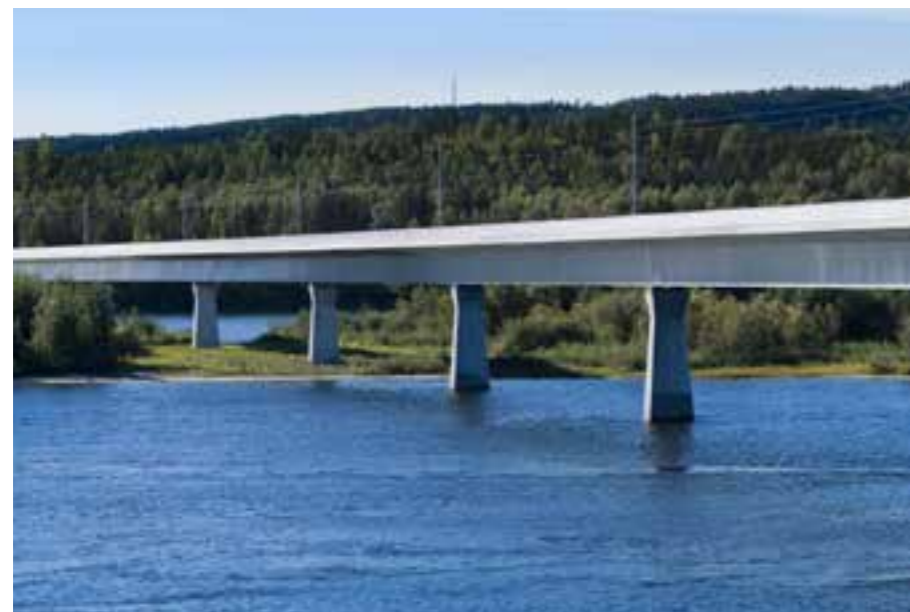
Figur 4.5.1 Exempel på samverkansbro med lådbalk.
