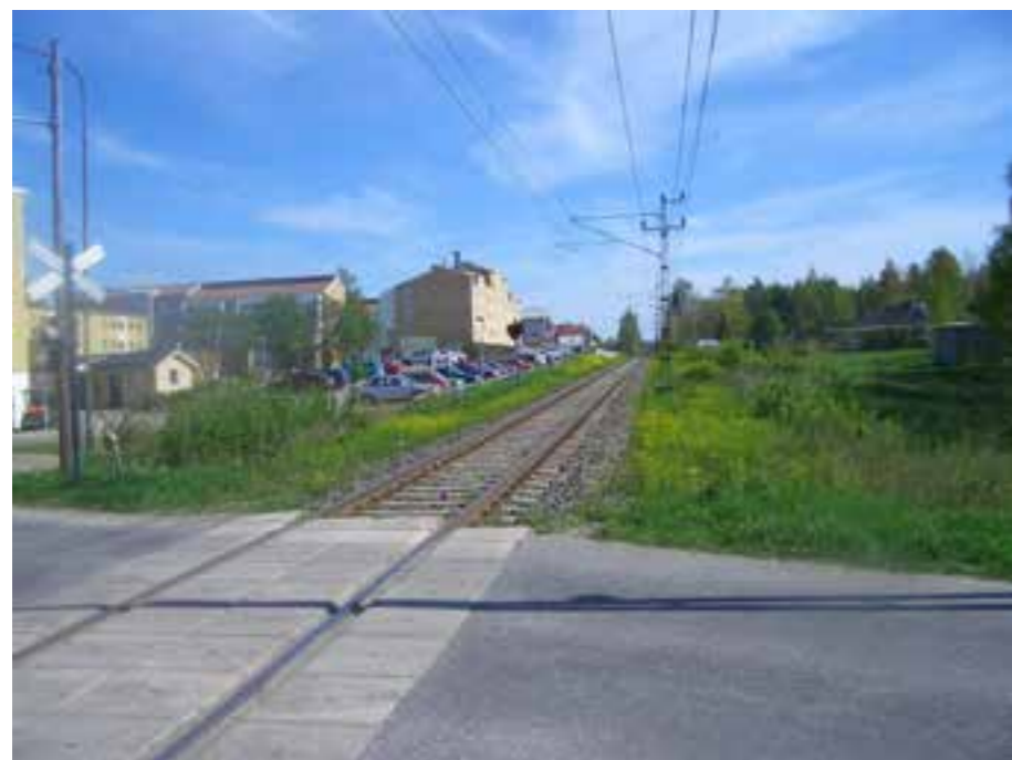
Figur 8.6.1 Befintlig järnvägssträckning genom Sörberge centrum. Både bosträder och annan bebyggelse ligger mycket nära spåret.
