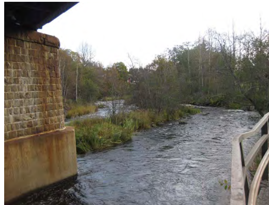
Figur 5.8. Gådeån vid Gådeå by. Till vänster syns fundamenten till den befintliga järnvägsbron.
