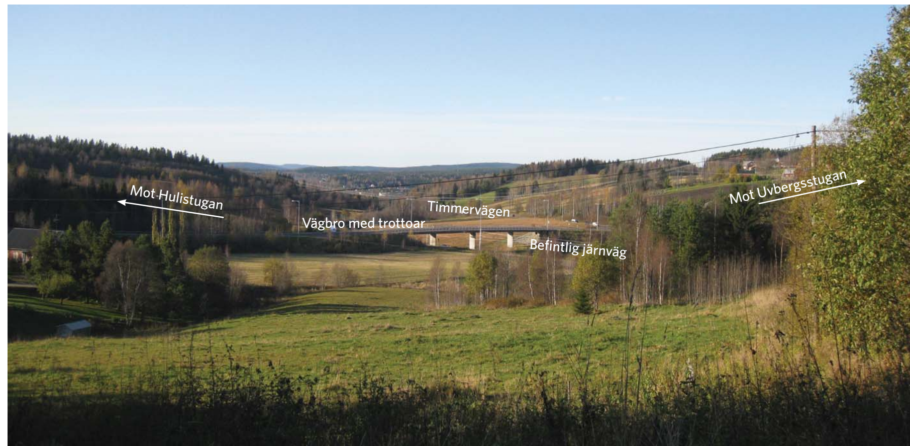
Figur 8.5.2 Bro över befintlig järnväg i Huli. Bron förbinder spårssystem kring Hulistugan med spåren kring Uvbergsstugan.
