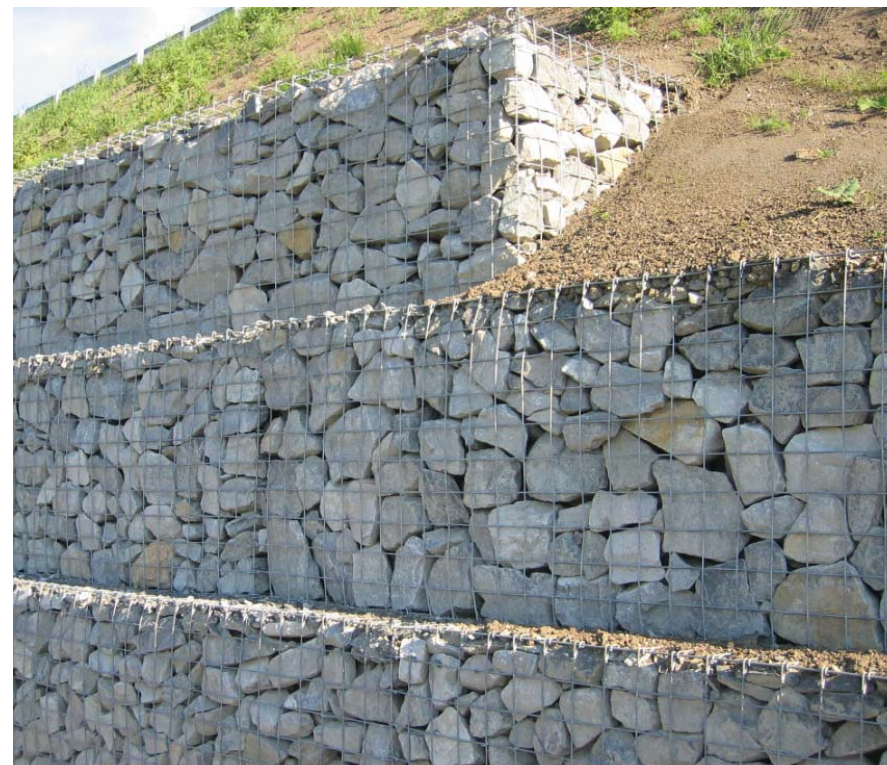
Figur 5.2.15 Exempel på gabionmur.
