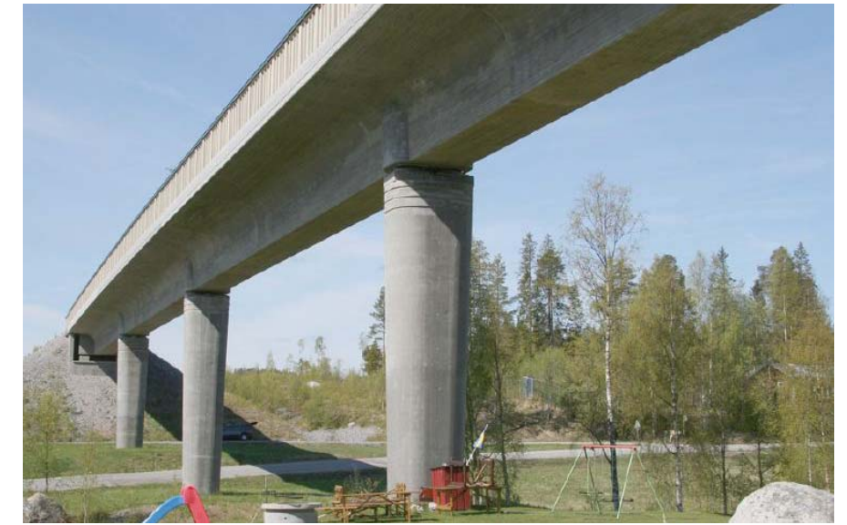
Figur 4.5.4 Exempel på betongbro.
