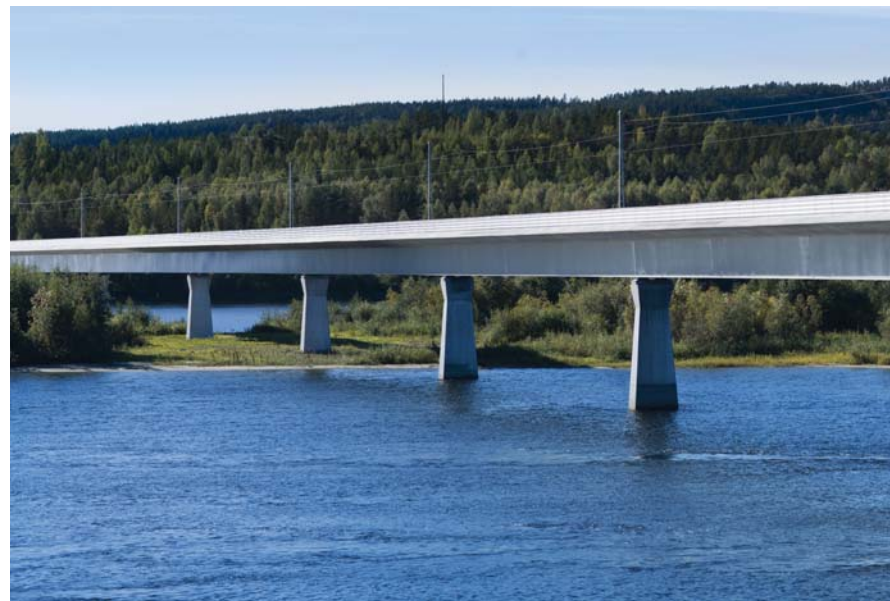
Figur 4.5.1 Exempel på samverkansbro med lådbalk.
