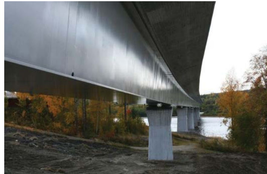
Figur 4.5.2 Exempel på samverkansbro med lådbalk.
