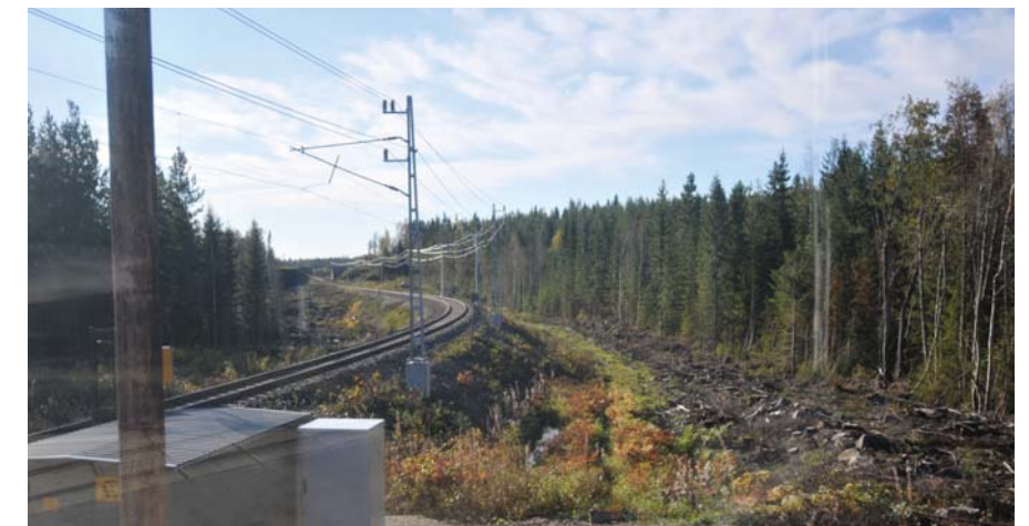
Figur 5.2.2 Järnvägen passerar skogslandskapet. Järnvägsbankarna är branta för att bevara mark. Låg estetisk bearbetningsgrad.
