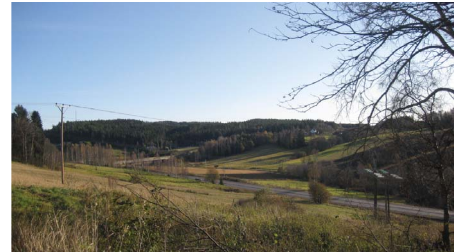
Figur 5.2.1 Järnvägen genom det småskaliga odlingslandskapet i Huli. Järnvägen förljer dalgångens riktning och smälter väl in i landskapet.
