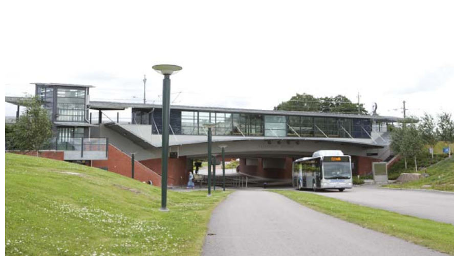
Figur 5.2.9 Falkenbergs station. Hög estetisk bearbetningsgrad vad gäller stationsbyggnad och vägport.
