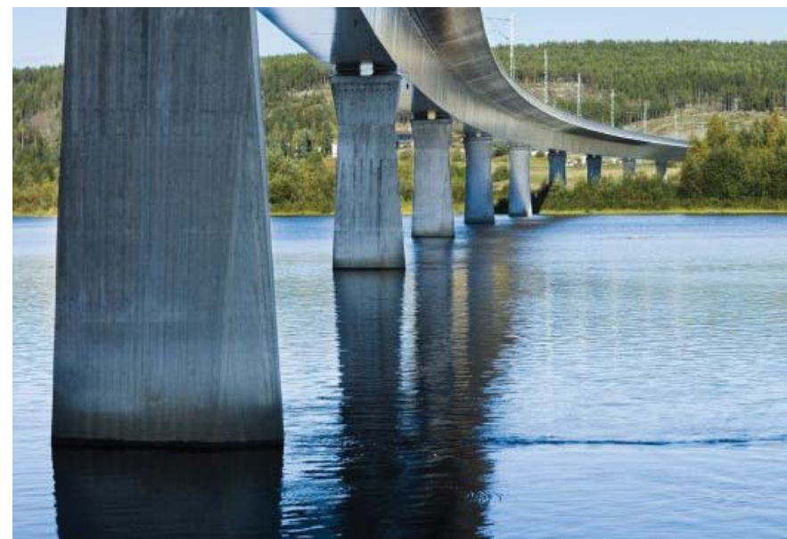
Figur 4.5.3 Exempel på samverkansbro med lådbalk.
