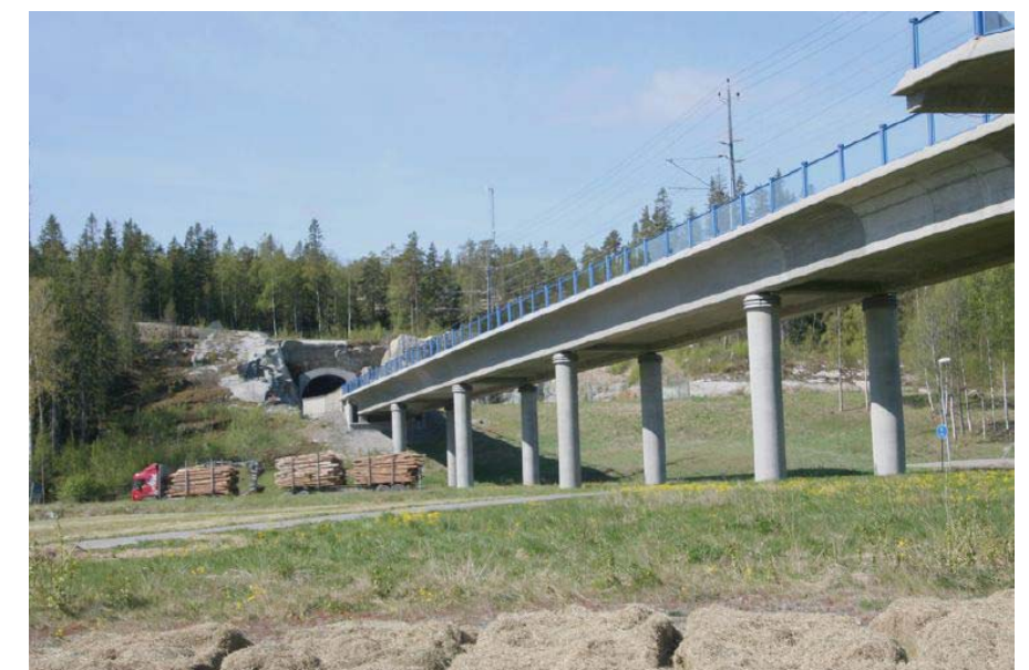
Figur 4.5.5 Exempel på betongbro.
