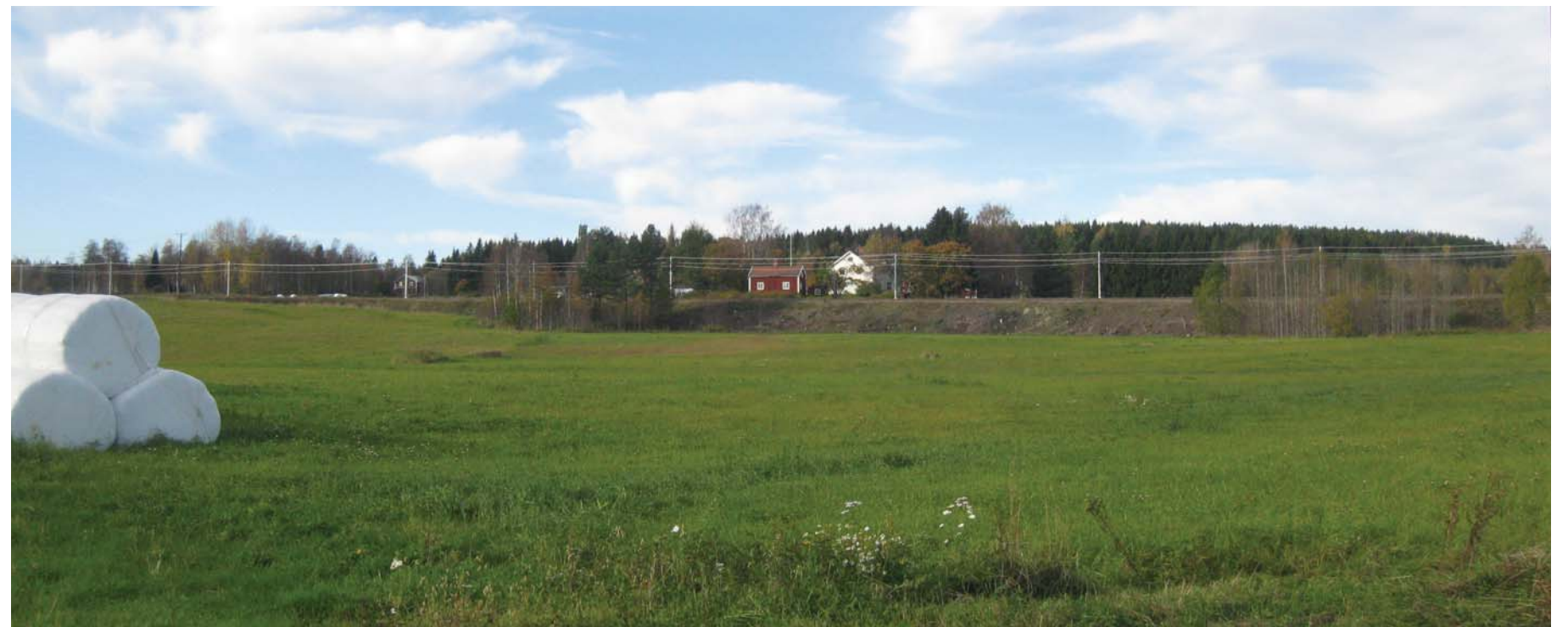
Figur 3.6.5 Järnvägsbank genom odlingslandskapet som utgör en barriär för de boende på vardera sidan av järnvägen, både visuellt och för rörelsen i området.
