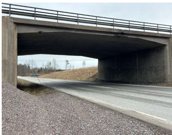
Figur 4. Bro över väg 529 vid Trafikplats Tälle.
