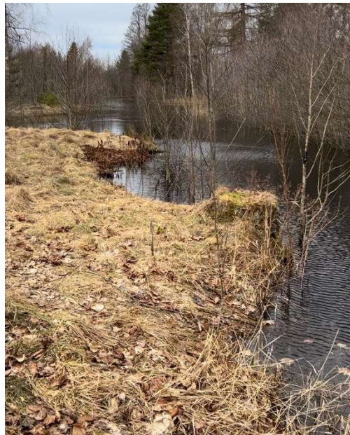
Figur 28. Damm vid Sumpen.
