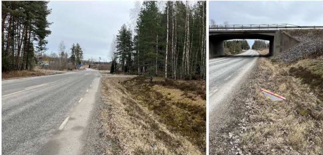
Figur 8. Bron där riksväg 50 passerar över väg 529. Bron är framträdande i landskapet.
