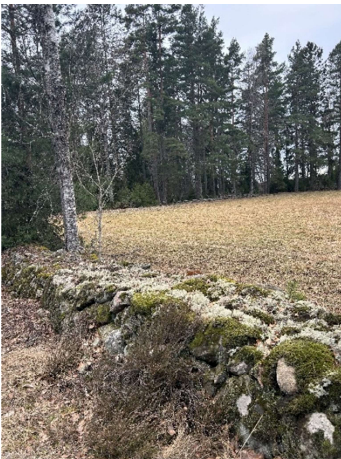
Figur 18. Stenmur norr om väg 529.
