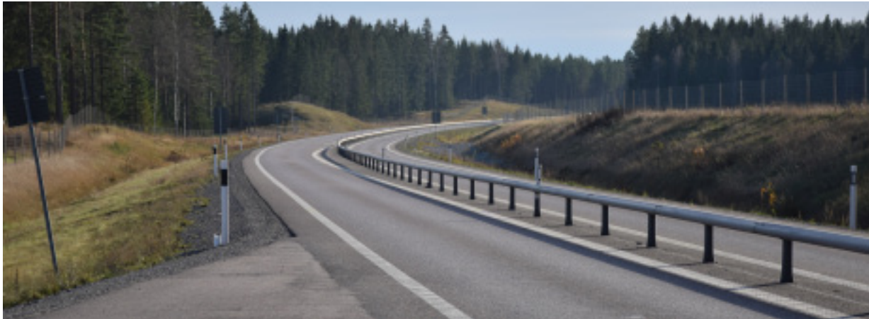
Ellipsformade räcken på rund stolpe ska användas i mittremsan.
