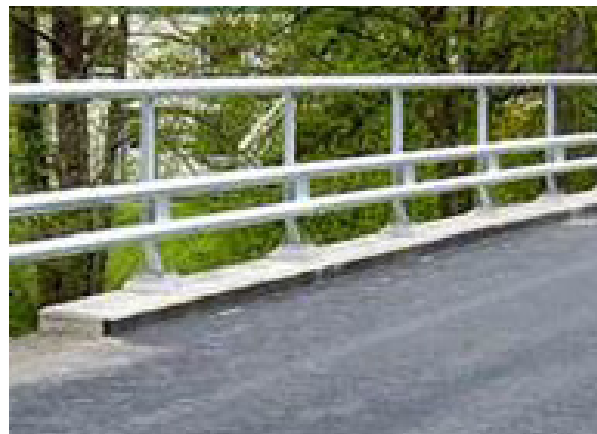
Räcken vid risk- eller skyddsobjekt ska ha kapacitetsklass H2/L2. Vid vattenskyddsområde enligt riskanalys.
