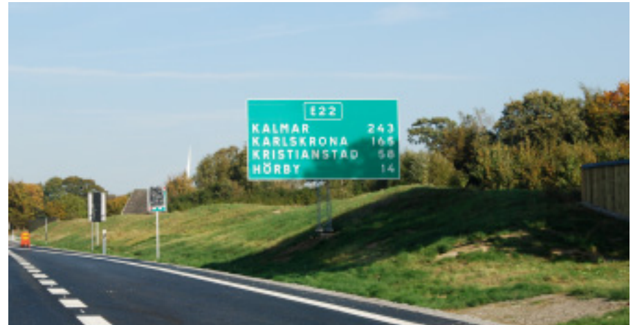
Skärm och vall i mosaiklandskap, där vallens form anpassats till omgivningen. Variation i höjd och sidled minskar intrycket av "limpa". Från E22 i Skåne.
