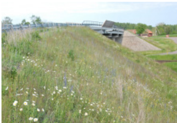
Genom att täcka sidoområden med avbaningsmassor från platsen kan man snabbt etablera en naturlig flora. Med regelbunden slätter kan man skapa blommande vägkanter.
