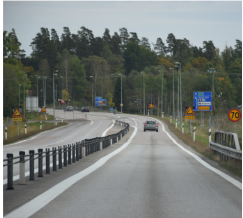
Idag är E20:s passage över Göta kanal svår för trafikanten att uppfatta då vägmiljön är rörig och svåröverskådlig. Trafikantupplevelsen av kanalen bör förstärkas genom att allén framhävs genom en upprepning av antalet skyltar och komplettering av alléträd. På aktuell E20-etapp som redan är mötesseparerad planeras dock inte några ytterligare åtgärder 2014-2025.
