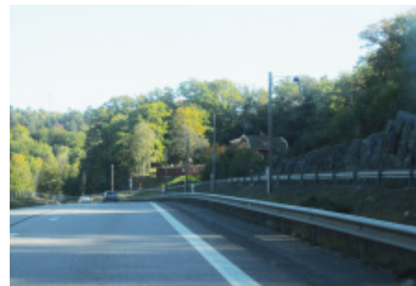
Exempel på de skilda karaktärerna som E20 passerar. I det småbrutna sprickdalslandskapet är vägbänor i olika nivåer ett sätt att bibehålla ett smalt vägrum som är följsamt i landskapet.
