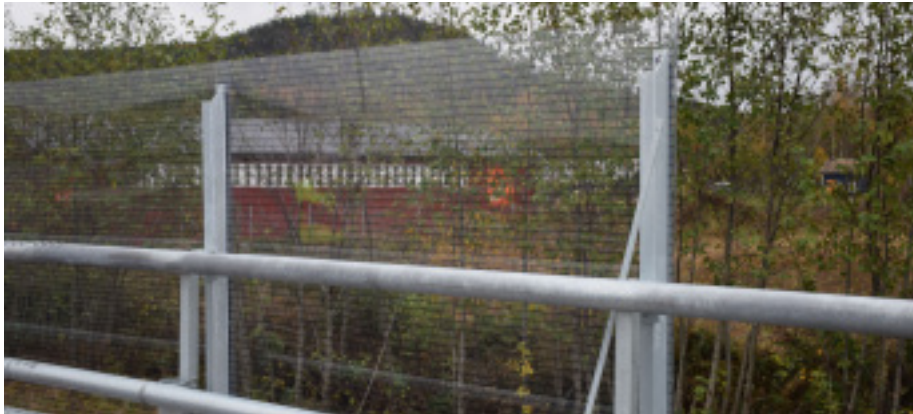
Där utblickar ska bevaras ska genomsiktliga skärmar användas. Om skyddsmarkeringar bedöms behövas av miljöskäl ska gestaltungsaspekter vägas in vid val av omfattning och utformning.
