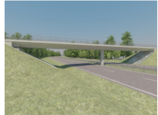
Alla slänter ska vara bearbetade och gräsbesådda.
