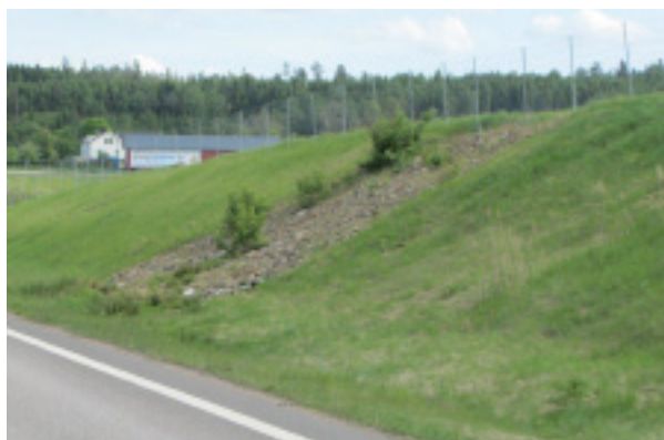
Jordklädda och grässådda ytor i sidoområdet motverkar slyuppslag, till skillnad från ytor med grovt krossmaterial där endast sly kan gro.
