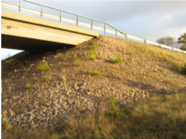
Befintliga brokoner som är obearbetade ska täckas med jord och besås.
