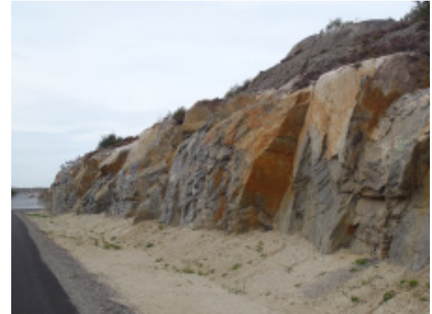
Naturlika bergskärningar bör utföras där det har betydelse för vägrummet och där det är lämpligt med tanke på bergkvaliteten.
