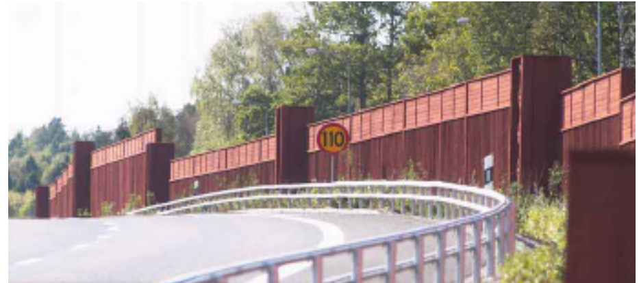
I delsträckor nära nyligen utförda bullerskyddsåtgärder ska nya skärmar utformas i samklang med de befintliga. Exempel från E20 vid Floda.
