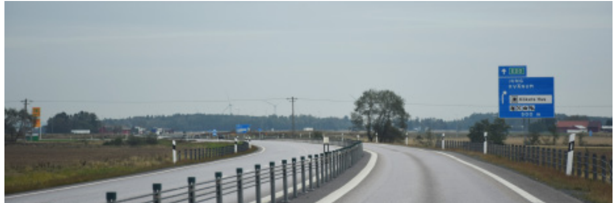
Utformning av trafikplatser ska anpassas till respektive landskapstyp. I slättlandskapet, som vid Jungs trafikplats, byggdes de nya anordningarna nedsänkta i förhållande till befintlig marknivå. Den öppna vyn har på så vis kunnat behållas.
