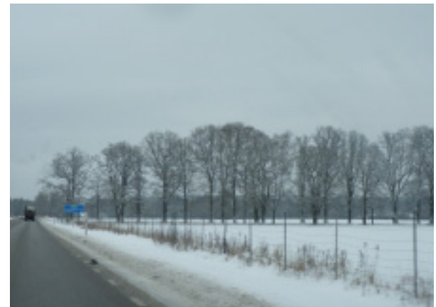
Viltängsel med stålstolpar bör väljas så att stängslet även kan placeras inom säkerhetszonen.
