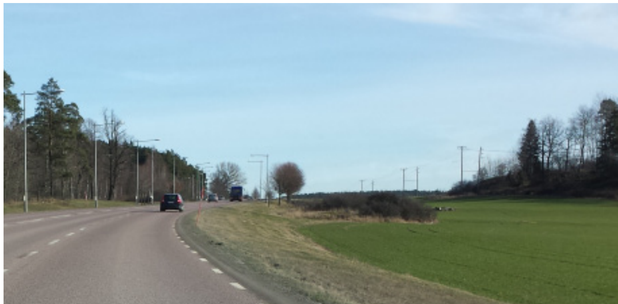
Sidområden ska utformas så att vägen får en naturlig förankring i det omgivande landskapet och anpassas till markens brukning. Ytor i sidoområdet ska kläs med jord som gynnar etablering av naturlig flora. Utrustning som försvårar skötsel ska undvikas.
