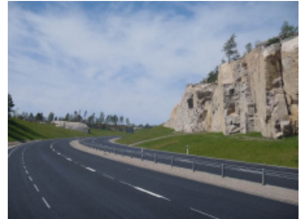
Bergskärningar och jordslänter skall utföras så att de blir ett tilltalande inslag i vägrummet. E6 strax norr om Tanumshede.
