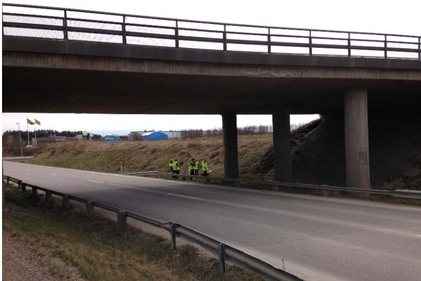
Figur 14. Befintlig bro under E20 vid trafikplats Vårgårda.
