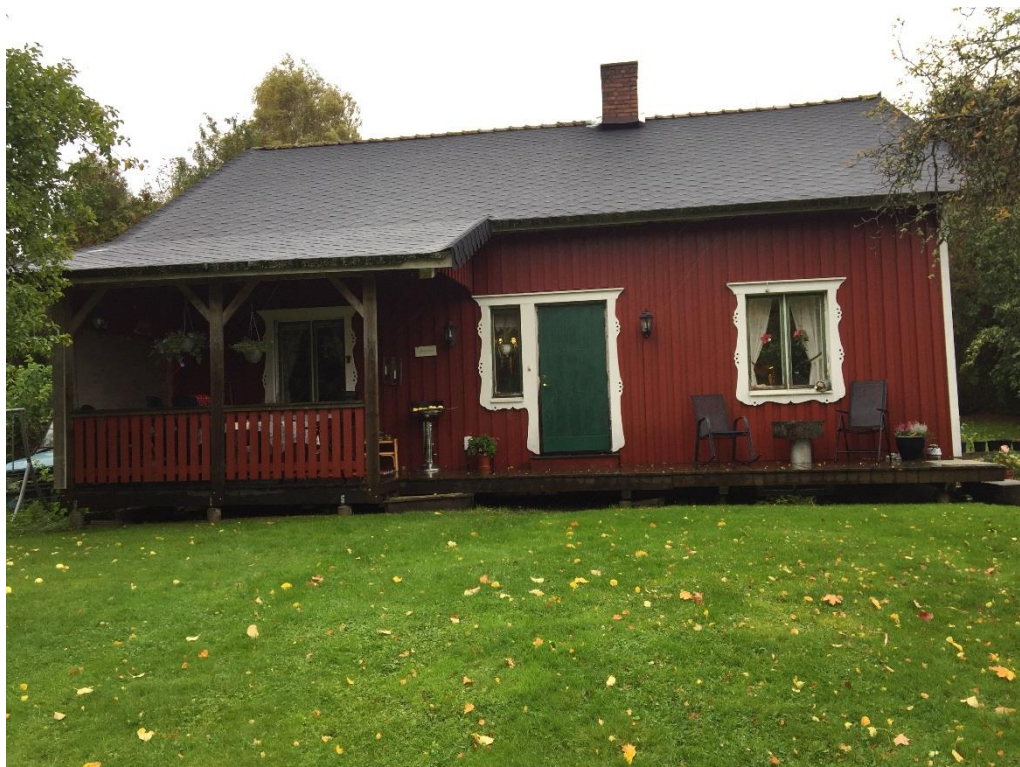
Fasad mot sydväst. Uteplats
