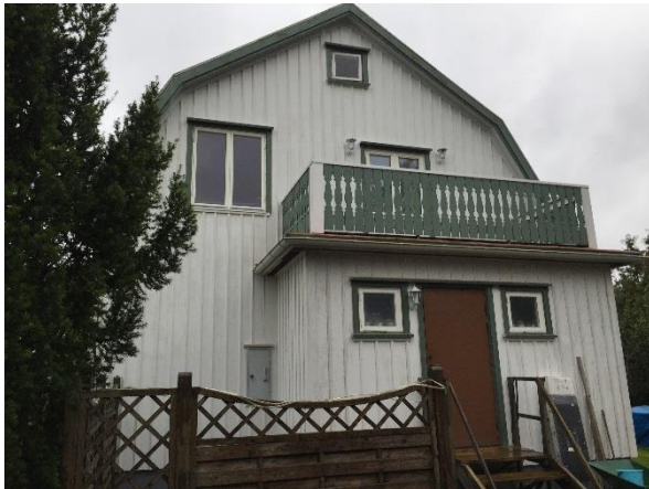
Fasad mot norr. Balkong
