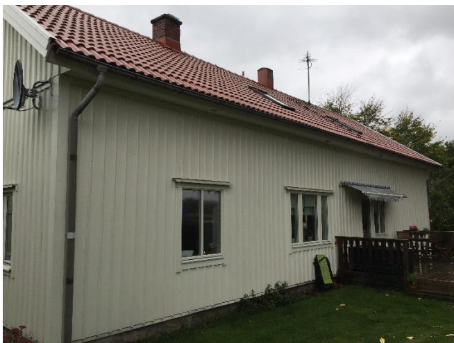
Fasad i öster. Uteplats
