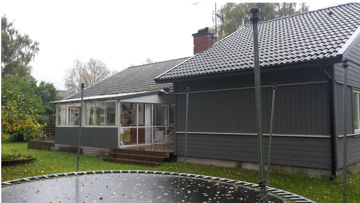
Fasad mot sydväst. Inglasad uteplats
