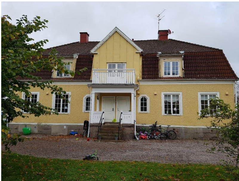
Fasad mot väster. Balkong
