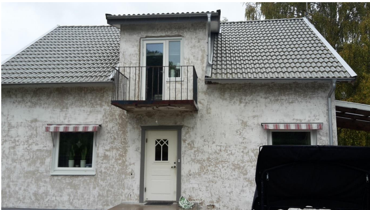
Fasad mot norr. Balkong
