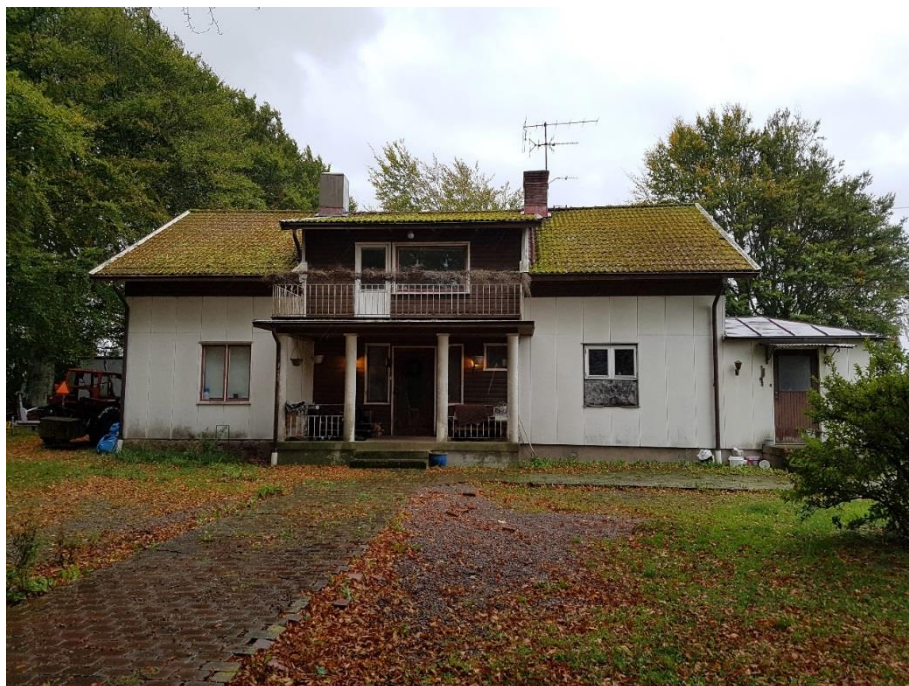
Fasad mot norr. Balkong och uteplats
