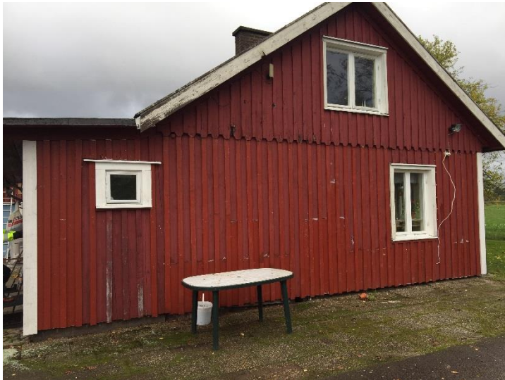
Fasad mot sydväst. Uteplats
