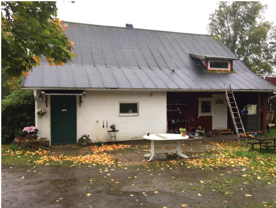
Fasad mot norr. Uteplats
