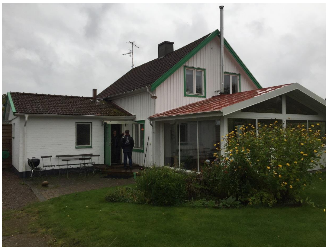
Fasad mot norr. Uteplats
