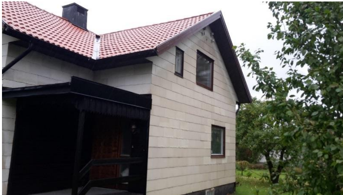
Hörn på sydöstra sidan
