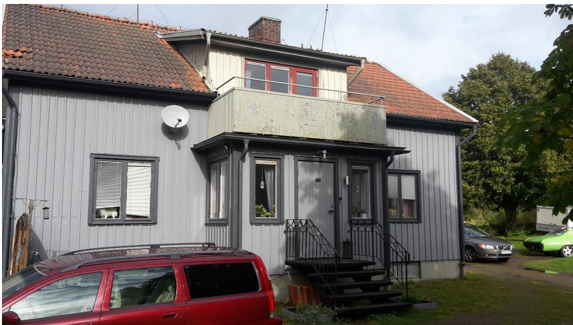
Fasad mot söder. Balkong
