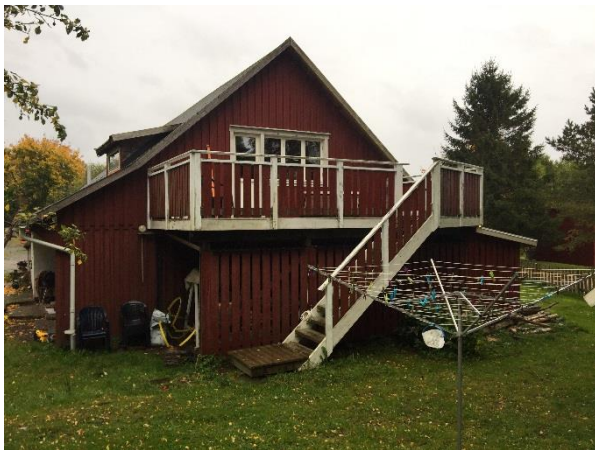
Fasad mot väster. Balkong
