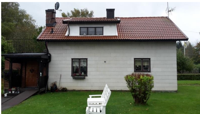
Fasad mot söder. Balkong i västra sidan
