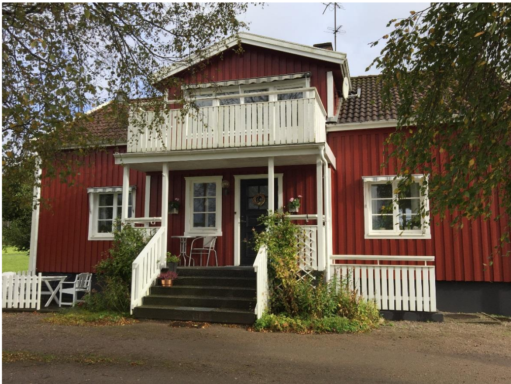
Fasad mot väster. Balkong och uteplats
