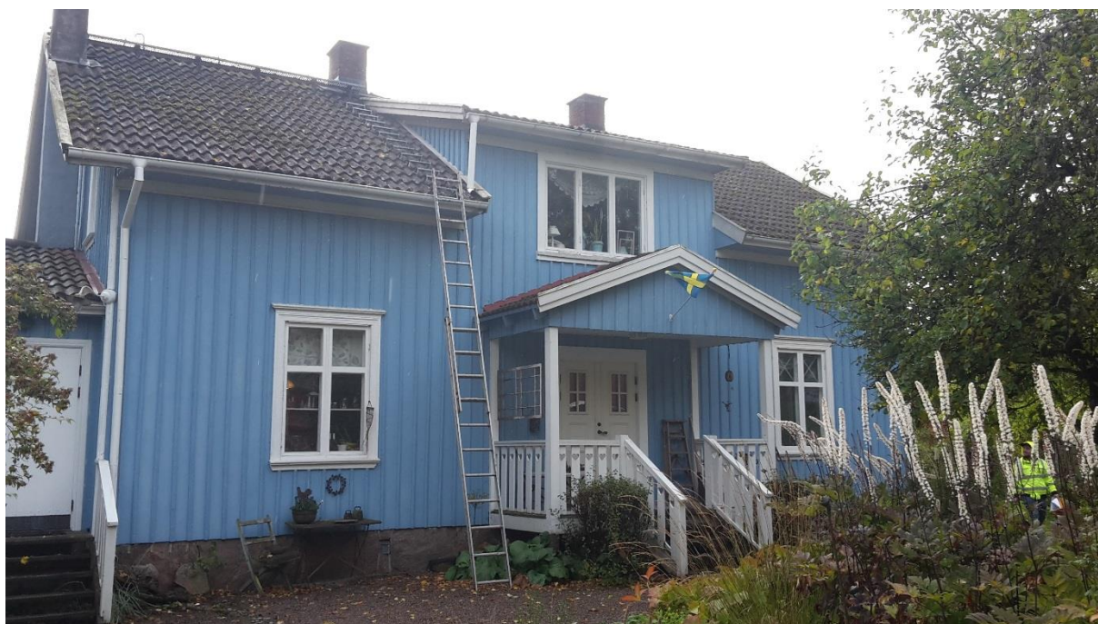
Fasad mot norr, uteplats
