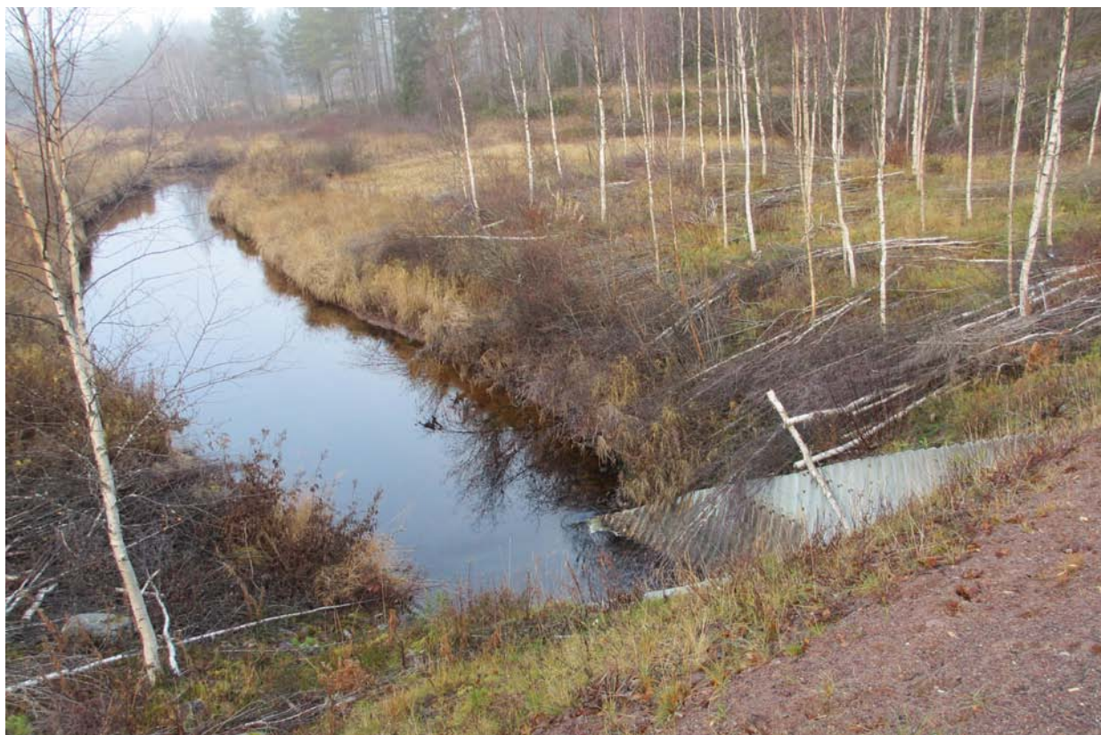
Figur 4.9 Vanån, vägens norra sida.
