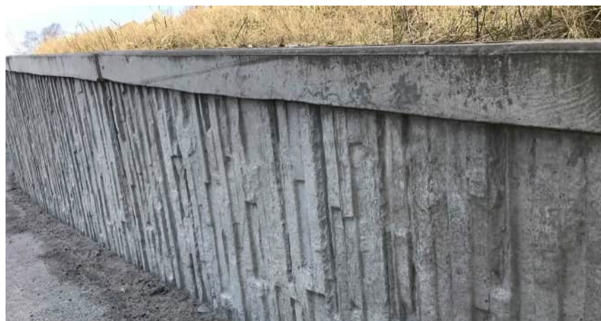
Figur 3.16 Befintlig stödmur vid Jungfruvägen. L-stöd med reliefmönster och tydligt markerad överkant.
