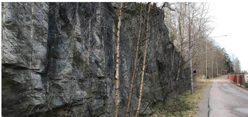
Figur 3.7 Befintlig bergskärning utmed sträckan.
