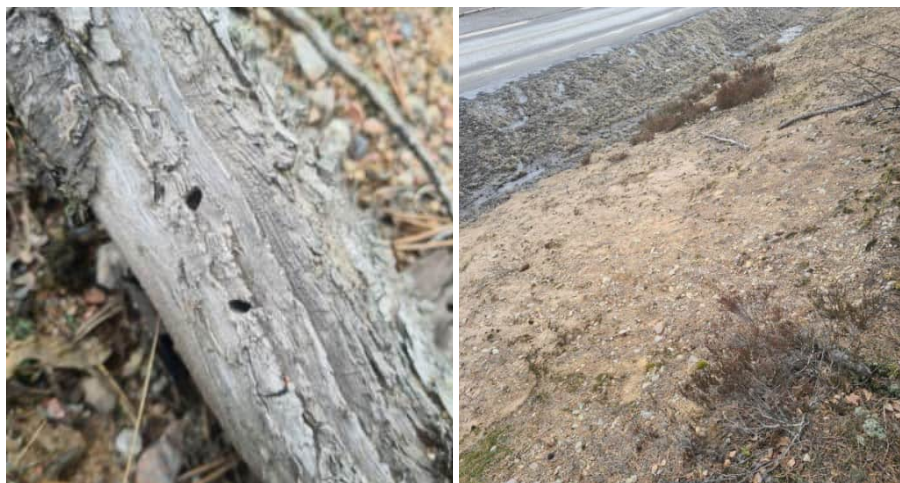
Figur 3.8 Befintliga foton från sandslänt längst med sträckan. Källa: PM Bedömning av slänt, (2023)
