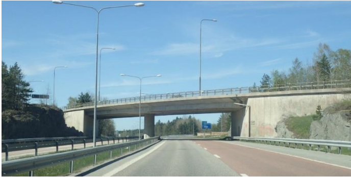
Figur 4:8 Bro 1-118-1 vid tpl Skrubba. En trolig sträckning av ny gång- och cykelväg är förhöjd där vägreolen är idag. Foto från BaTMan.
