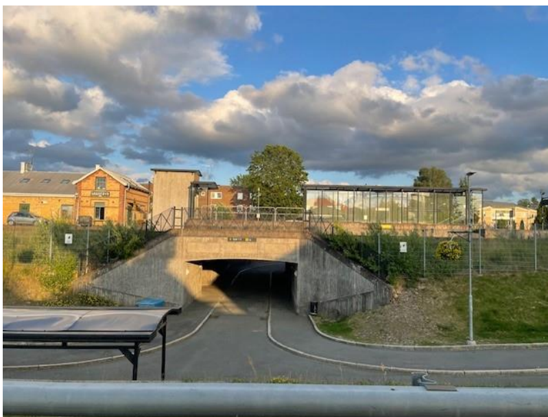
Figur 12. Vaggeryd station. Vy från Nådistigen mot sydost.
