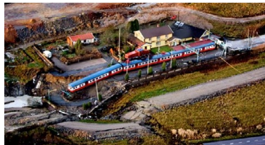
Figur 96. Exempel på skred.
