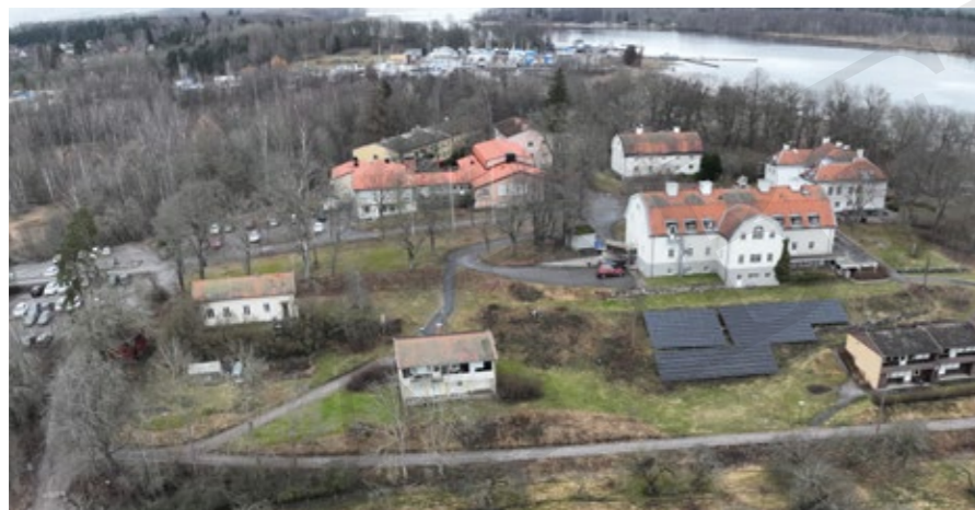
Figur 43. Marieborgs herrgård är byggnadsminnesförklarad. Huvudbyggnaden från sjön.
