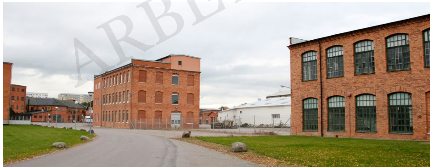
Figur 46. Vid infarten till Kvarteret Vulkans industriområde betonas bebyggelsens gemensamma nämnare i storskalig volym, flertalet solitärer, fasader i rött tegel med mönstermurning, regel-bundna fönsterband och ursprungliga fönster, vilket tillsammans lyfter fram området's homogena karaktär.
