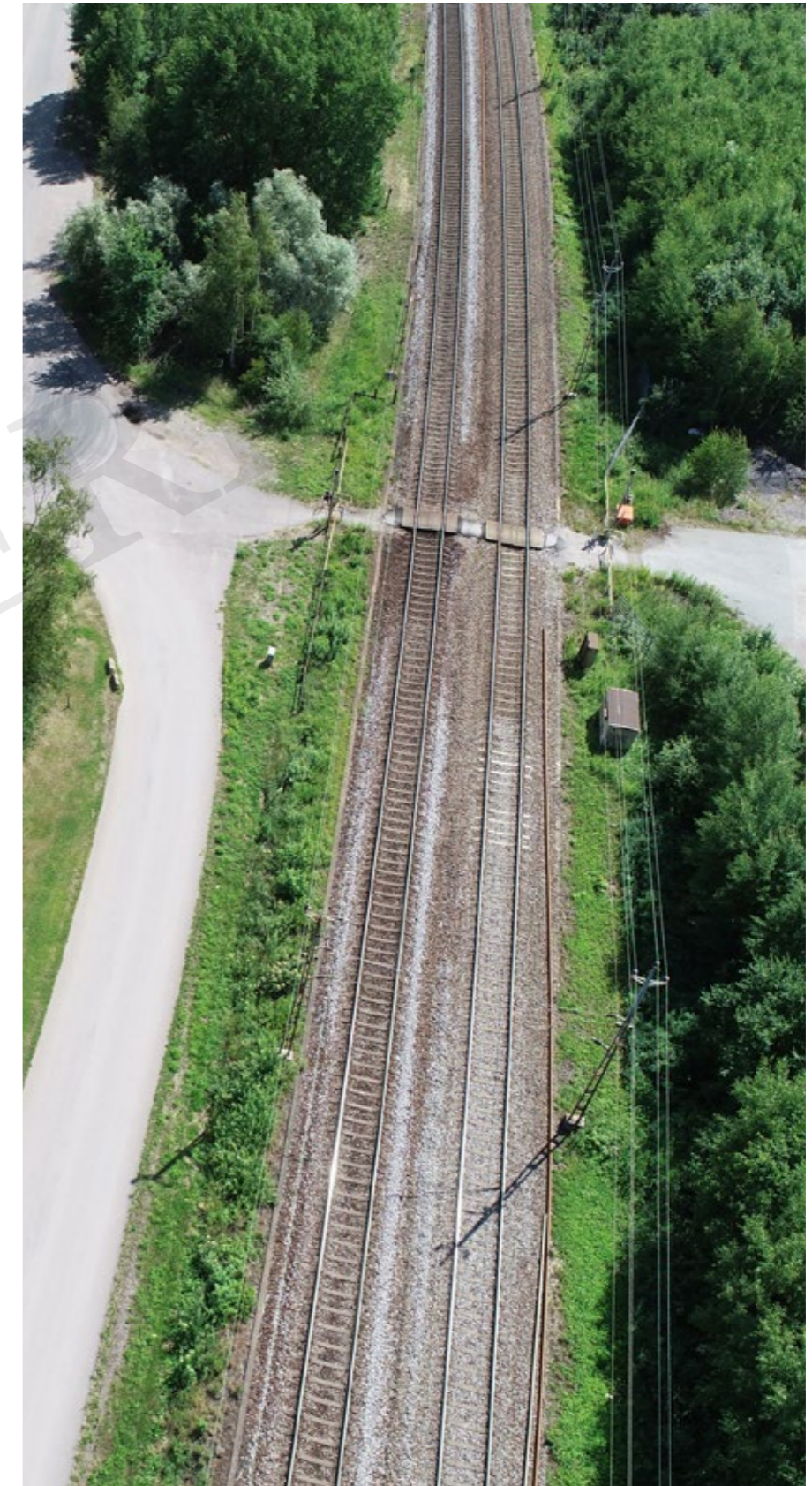
Figur 113. Drönbild över befintlig gångpassage i plan längs Södra stambanan mellan Kommendantvägen och Malmgatan.
