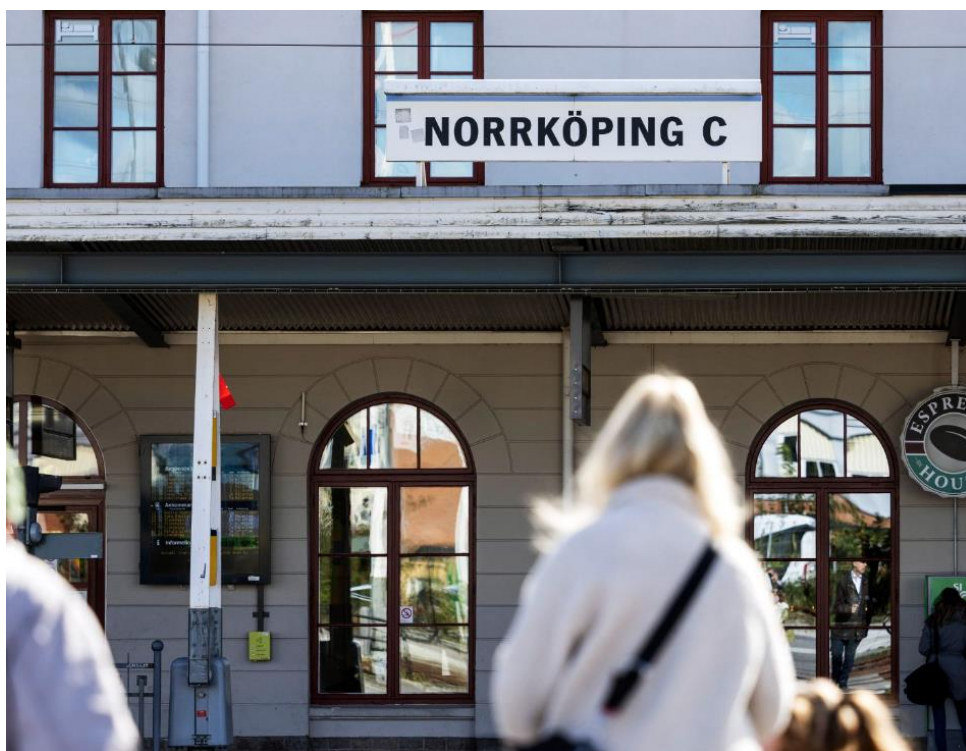
Figur 47. Del av stationsbyggnaden vid Norrköpings befintliga centralstation.
