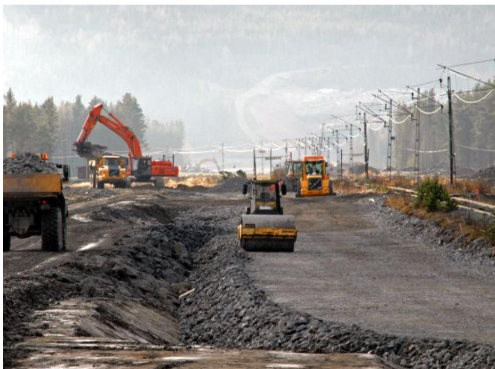
Figur 57. Exempel på hur anläggningsarbetet kan se ut vid byggnation av Ostlänken, delen Loddby-Butängen.
