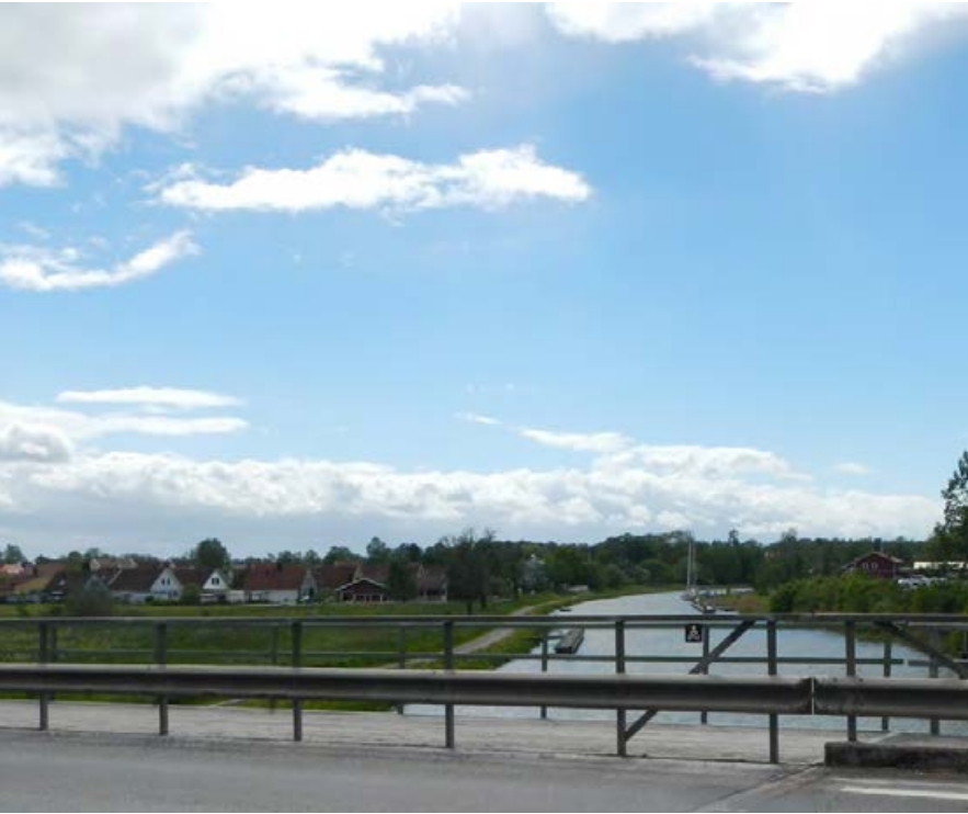
Väg 215 över Göta kanal vid Norsholm.
