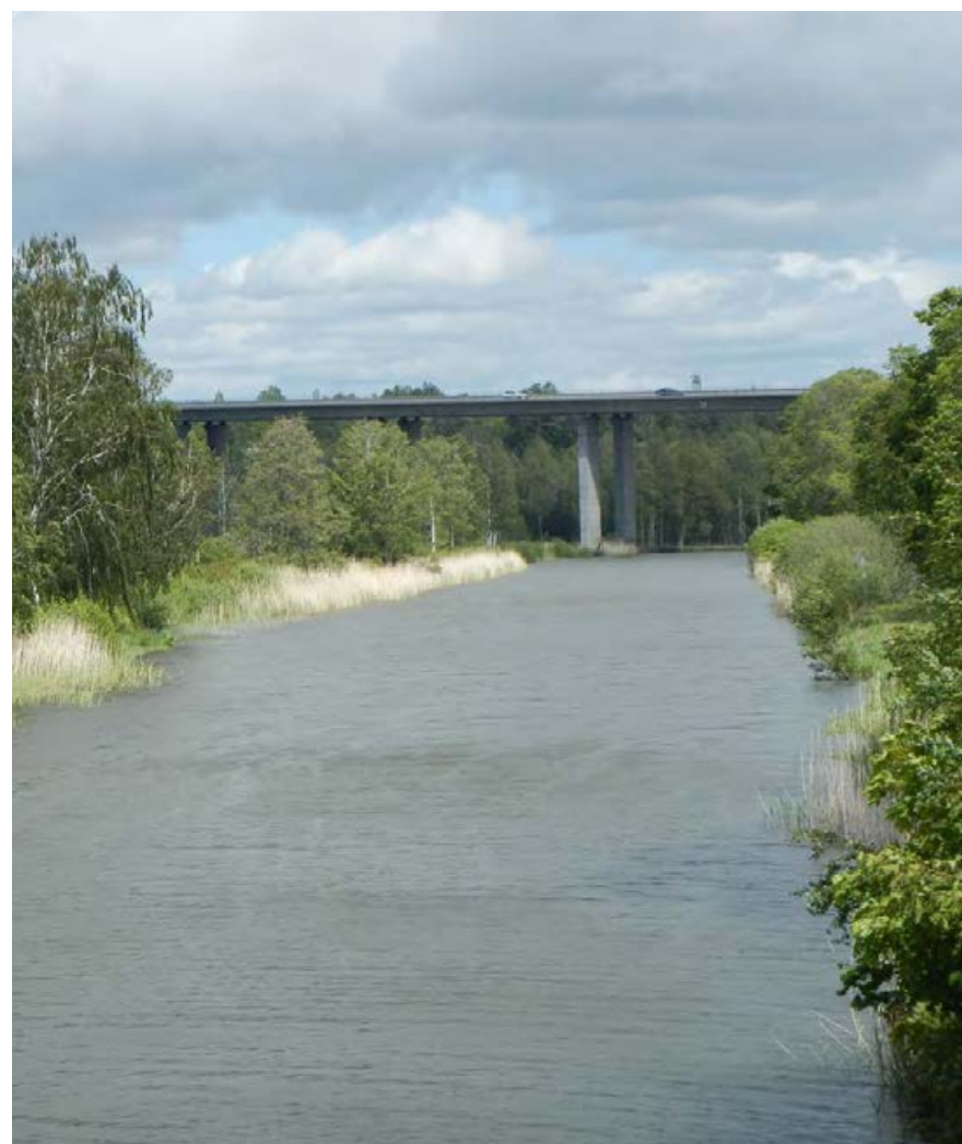
Norsholmsbron över Göta kanal sett från väster.
