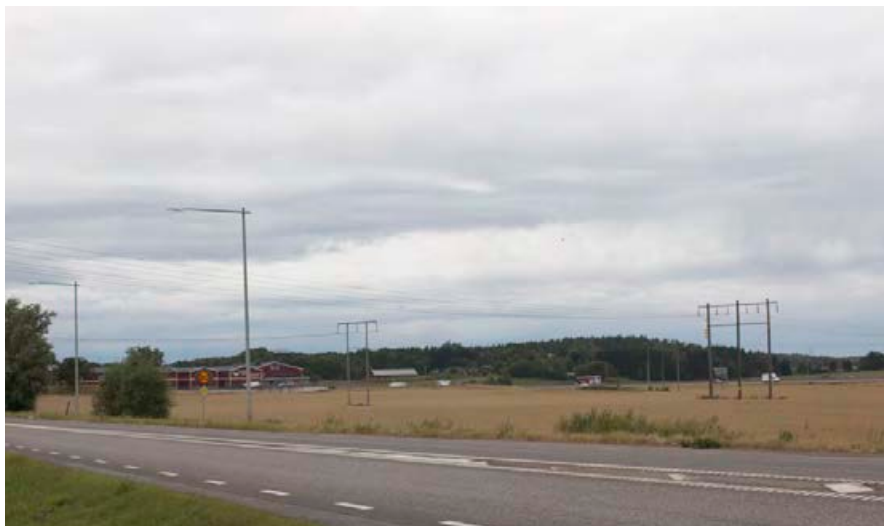
Vy norrut över åkerlandskapet vid Skälv. Vägen mot Norrköping syns i förgrunden och E4 i bakgrunden.
