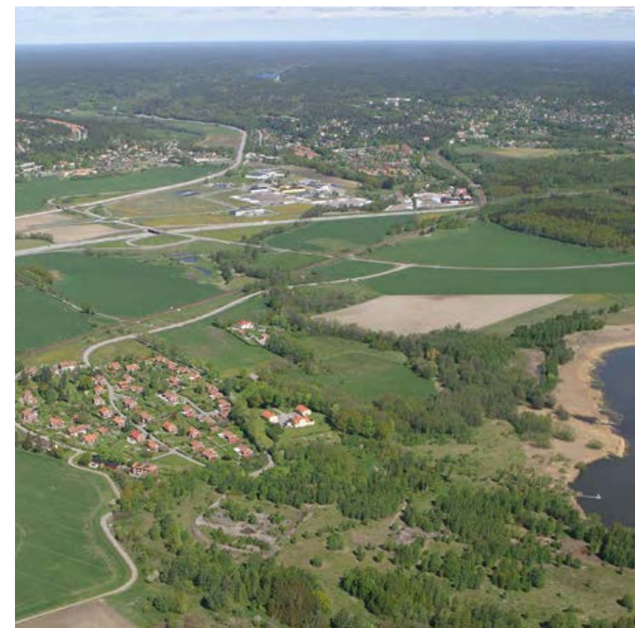
Flygfoto över Loddby i förgrunden och stambanan, E4, väg 55/56, Jursla och Åby längre bort i bilden.
