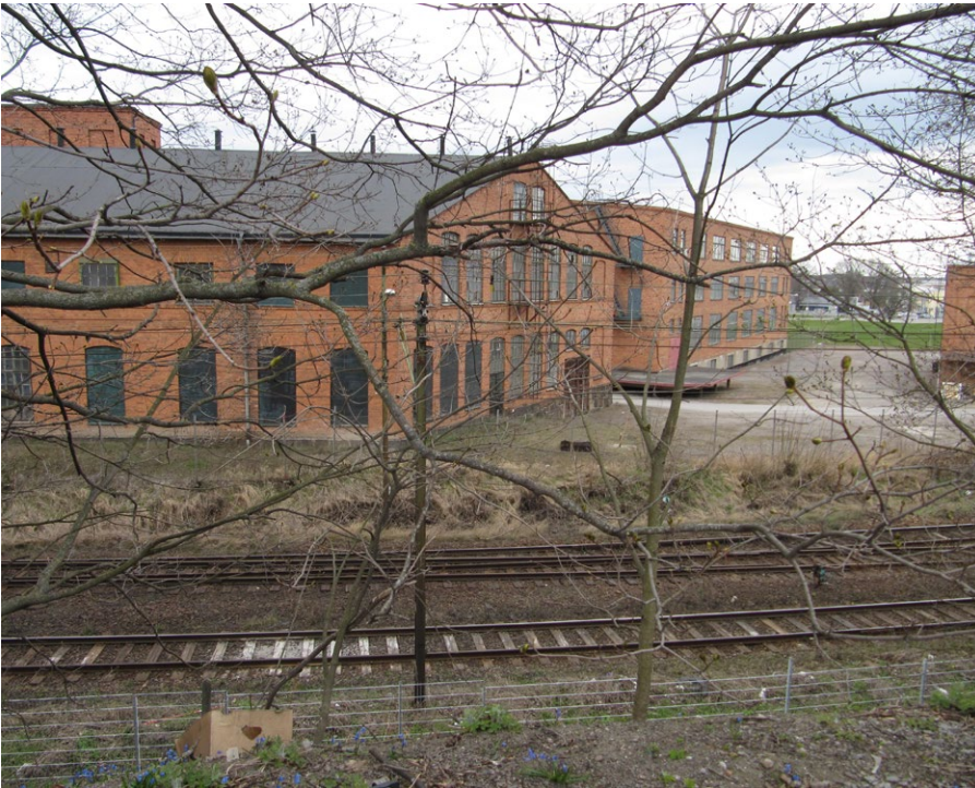
Kvarteret Vulcan sett från väster om södra stambanan.
