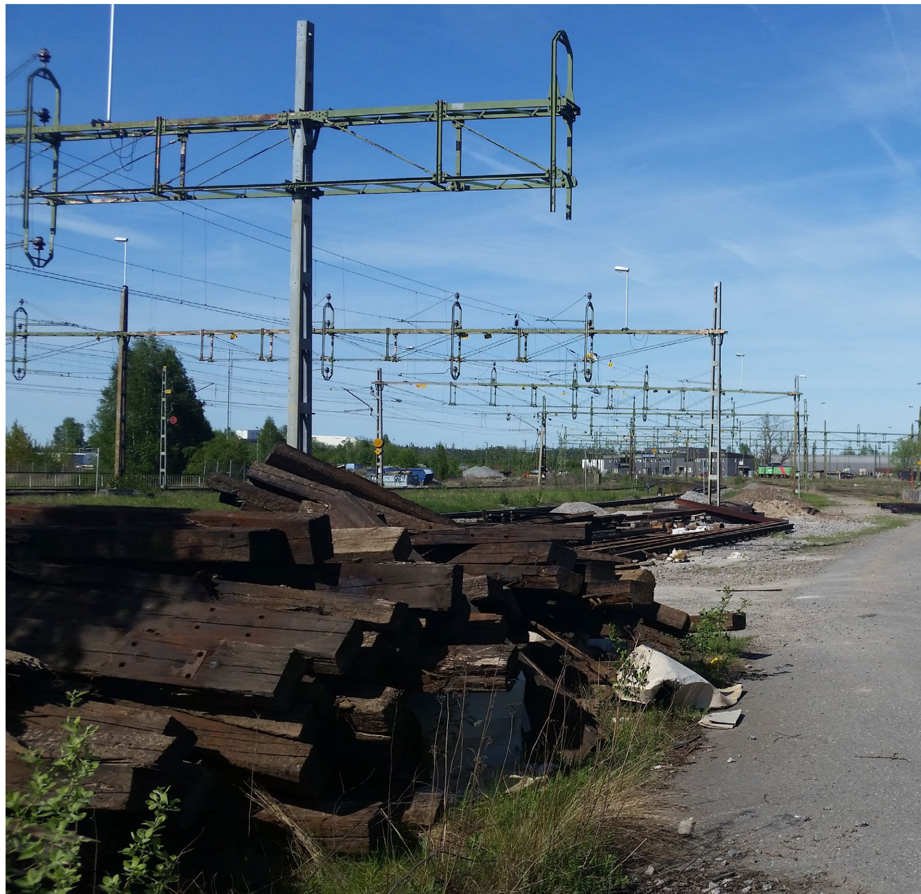
Slipersupplag och spår i Butängenområdet i Norrköping strax öster om nuvarande resecentrum.
