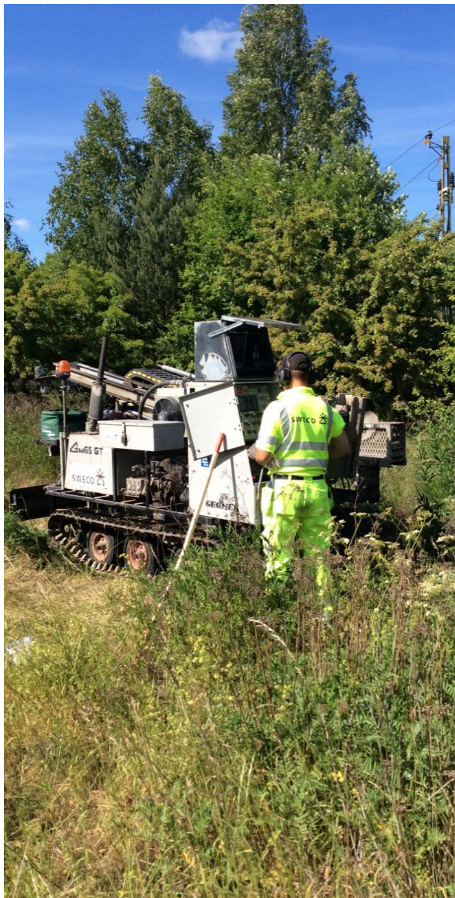
Miljöprovtagning med hjälp av skruv och borrhandsvagn för Ostlänken i Norrköping 2016. På bilden fältgeotekniker Hans-Olof Back, Sweco.
