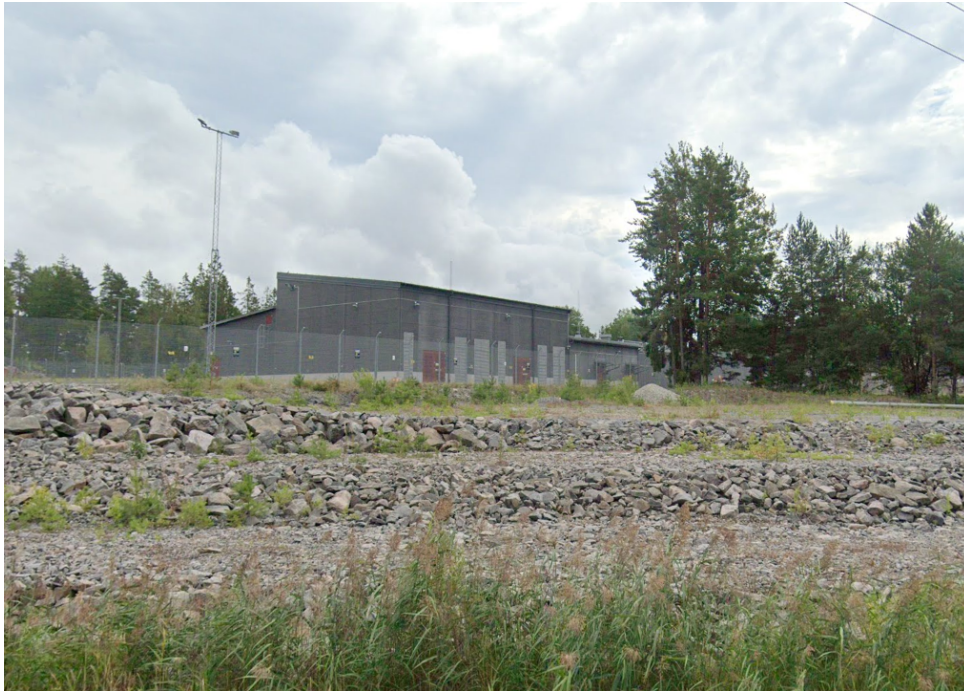
Figur 15. Exempel på befintlig omformarstation vid Järna, Södertälje kommun. Bild från Google maps.
