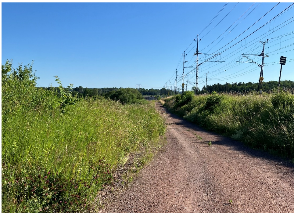
Figur 6. Befintlig serviceväg längs Södra stambanan. Bild tagen i riktning mot norr.
