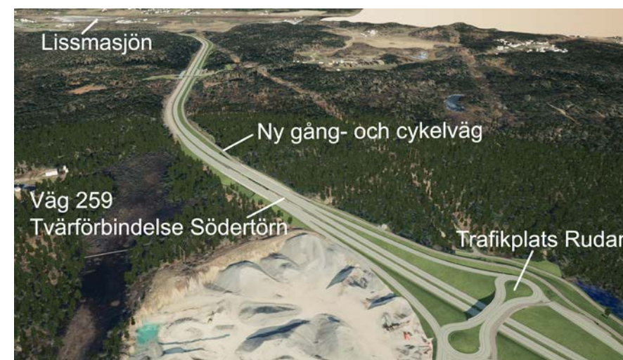
Figur 5.28. Gång- och cykelväg vid Rudan, sett österifrån. Ny gång- och cykelväg går parallellt med tvärförbindelsens norra sida.
