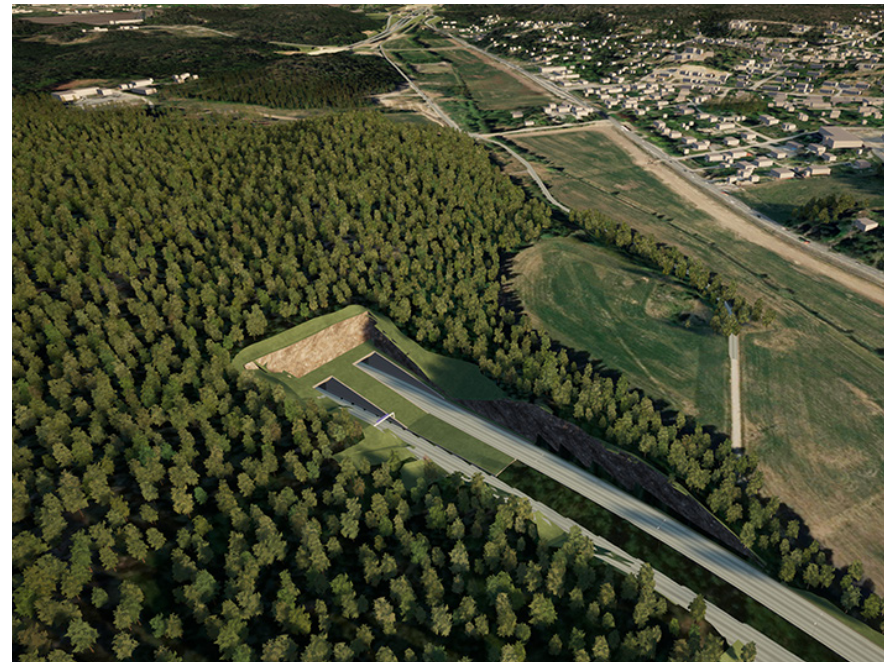
Figur 5.15. Glömstatunnelns östra mynning sett från öster.
