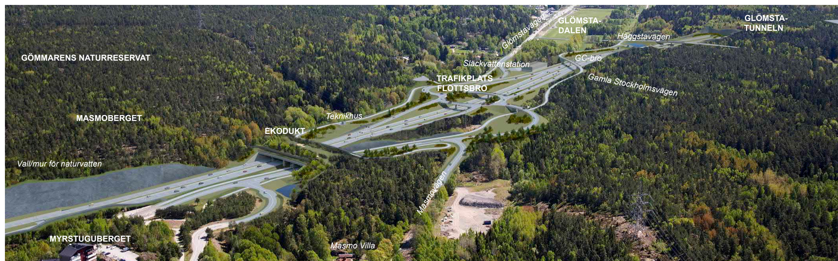
Figur 6.3.5 Översikt av delområde 3, med förskärning till tunnel till vänster, följt av ekodukt och trafikplats Flottsbro, bro för gång- och cykelväg, bro för Häggstavägen och tunnelmynning till Glömstatunneln längst i öster.
