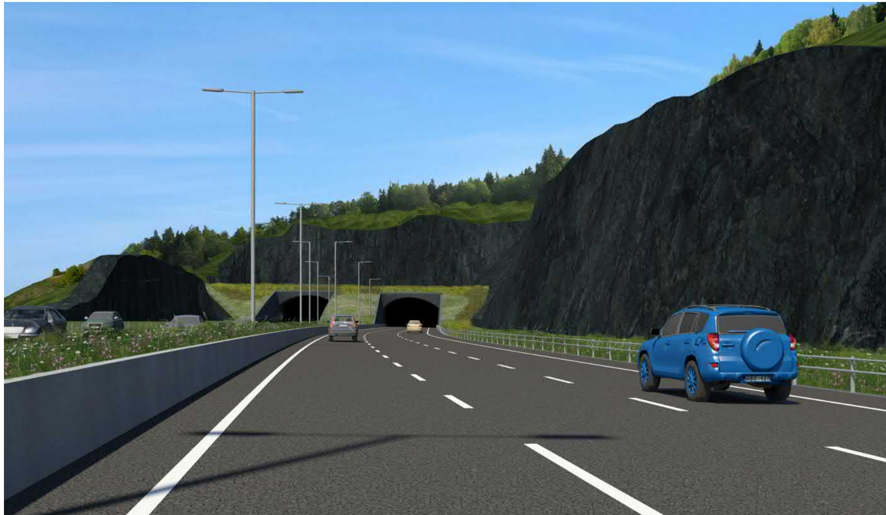
Figur 4.2.2 Förskärning vid Masmotunnelns östra mynning
