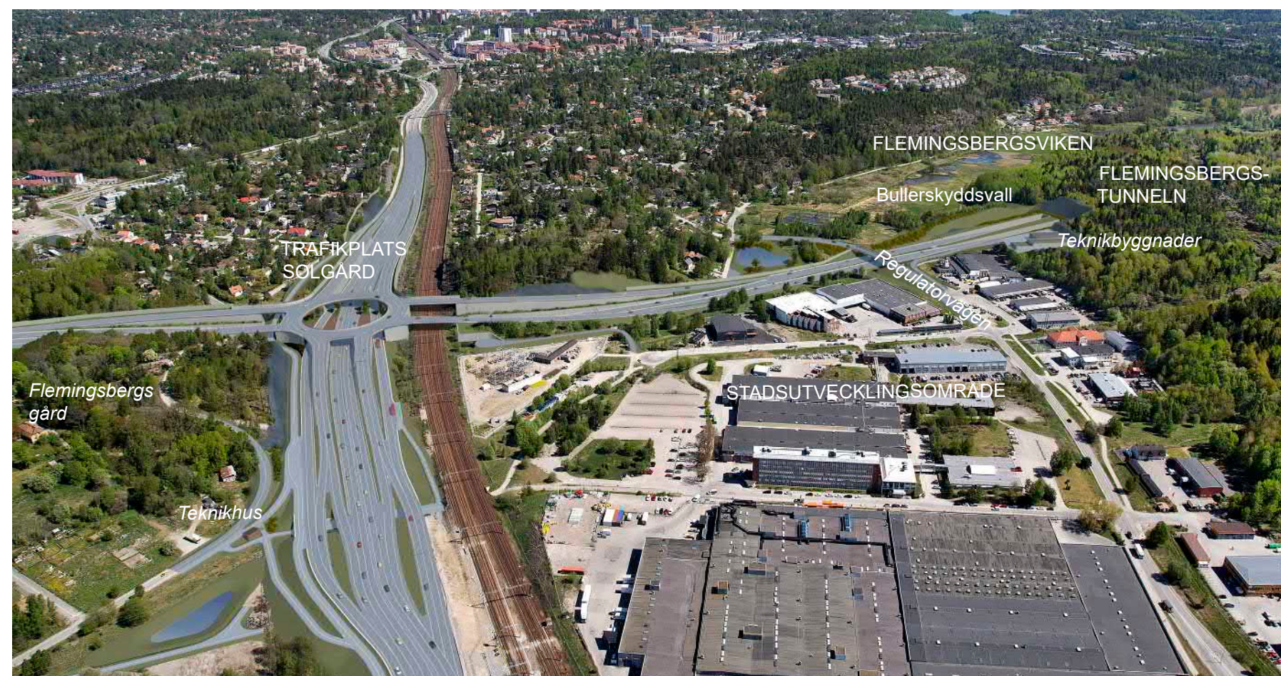
Figur 6.5.3 Översikt av Flemingsbergsdalen med väg 226 och Västra stambanan till vänster, gång- och cykelpassage nedtill till vänster, bro Regulatorvägen och mynning till Flemingsbergs-tunneln längre till höger.
