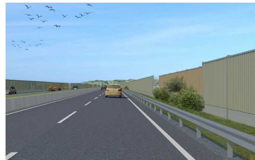
Figur 5.1.8 Exempel på bullerskyddsskärm på mark, med sidoförskjutningar.
