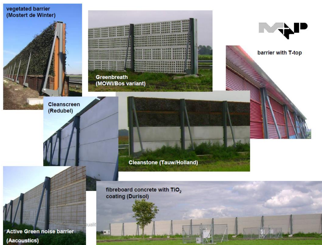
Figur 10. Olika skärmar vars effekt på NO x , NO 2 och PM 10 studerats av Hooghwerff et al. (2010).
