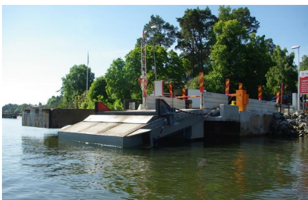
Figur 5. Byggd kaj vid Norra Lagnö. Källa: Atkins.
