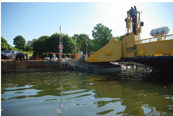
Figur 7. Byggt kaj vid Tynningö. Källa Atkins.
