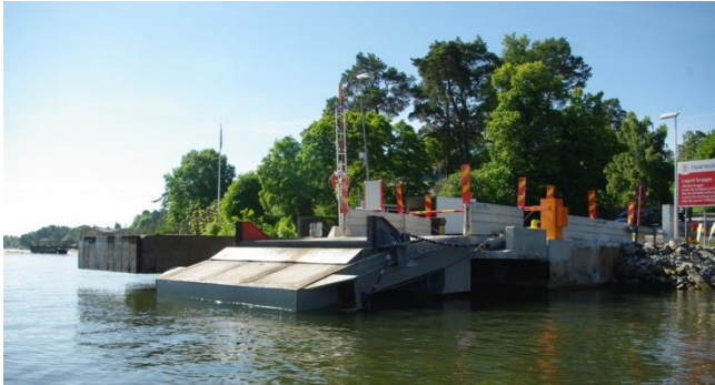
Figur 4 - Ombyggt färjeläge Norra Lagnö
