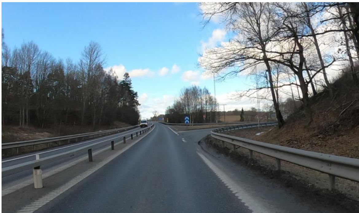
Figur 4. Befintlig påfart vid Åsens gård söderut på väg 26. Foto: Sweco.
