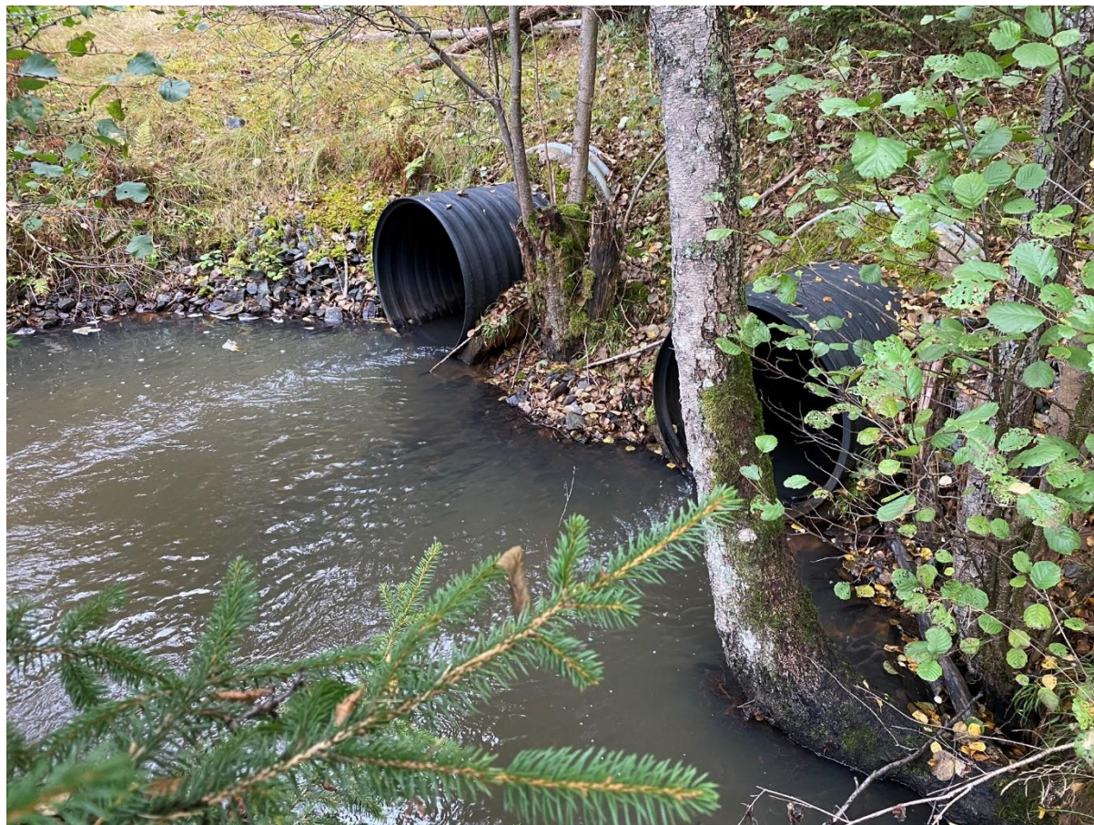
Figur 19. Foto av dubbeltrumman vid utloppet av Dunkehallaån. Foto: Sweco
