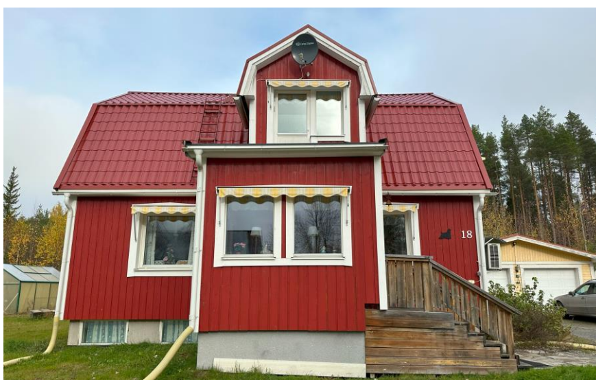
Figur 1. Fasad mot väg 605 (mot syd)
