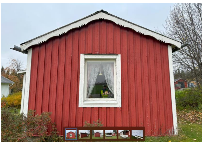
Figur 1. Fasad mot väg 605 (mot öst)
