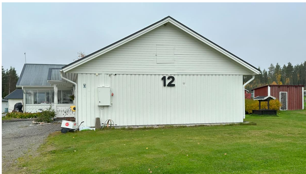
Figur 1. Fasad mot väg 605 (mot öst)
