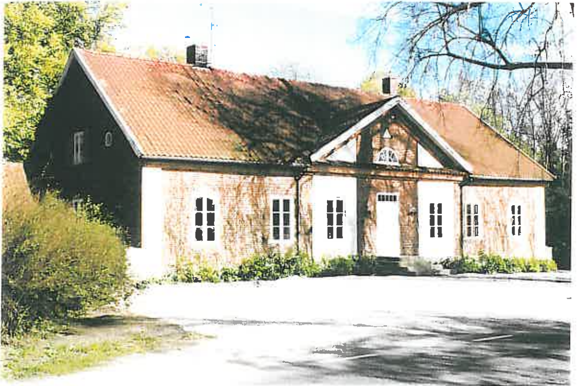
Bild 1. Farmen Gustavsält, uppförd omkring 1813, ligger utmed Wrangels allé med ekonomibyggnaderna på andra sidan vägen. Boningshuset är som på de flesta av farmarna en påkostad tegelbyggnad i nyantik stil.
