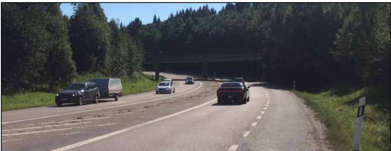
Järnvägsbro över väg 86/Timmervägen vid Nacksta
