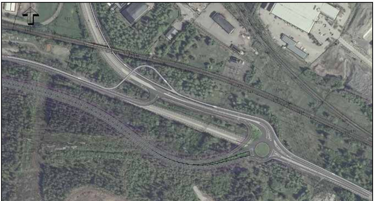
Figur 5.3:7 Ombyggnad av befintlig cirkulationsplats
