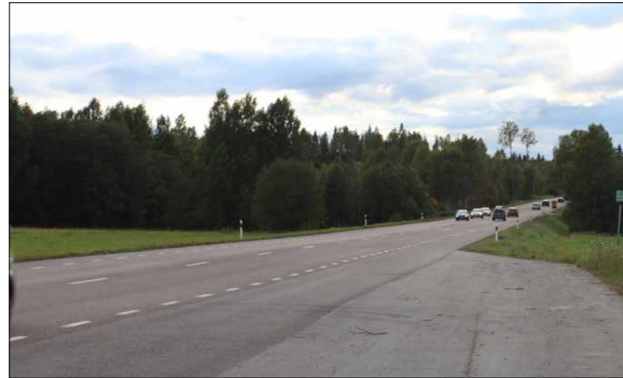
E14 är ca 13 meter bred på sträckan väster om Sörknävlan. Vy mot väster.
