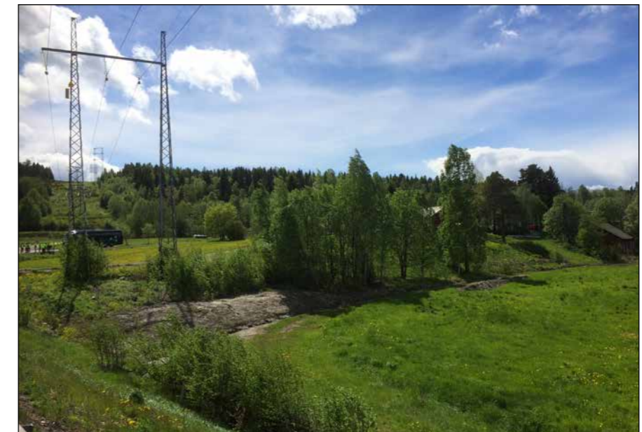
Kraftledningsgatan vid Selångersfjärden/Timmervägen. Vy mot söder.
