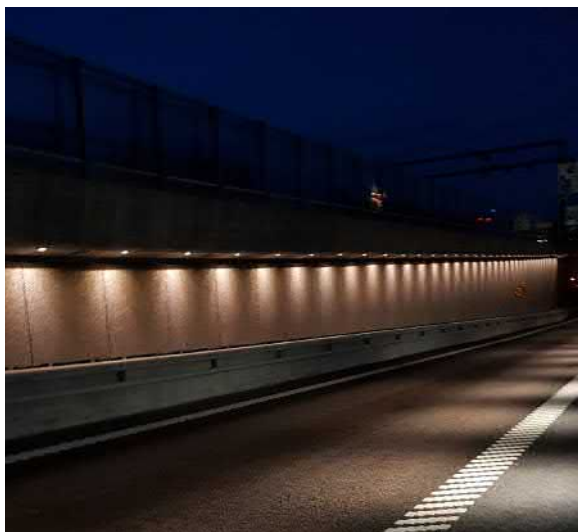
Bild 22. Exempel på utförande av belysning för den västra bron vid den planskilda korsningen i Nacksta. Foto: Maria Wipp
