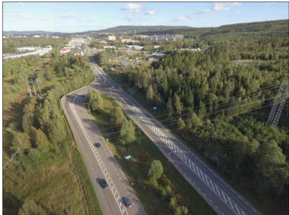
Figur 2.2:1 Befintlig cirkulationsplats som ansluter väg 86 Timmervägen och E14. Vy mot öster, Nacksta/Sundsvall i fonden.
