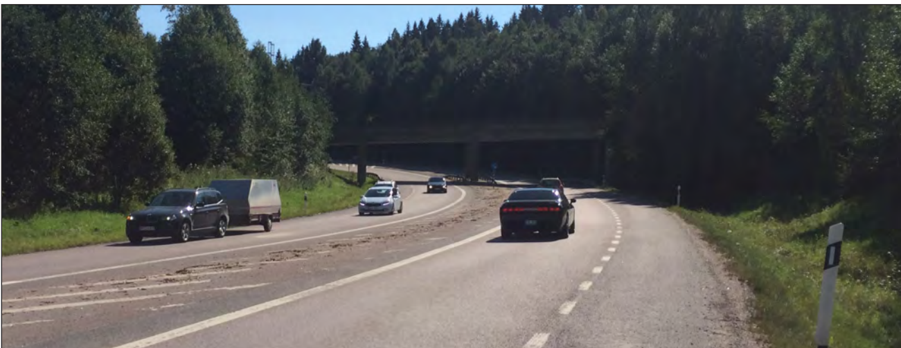
Järnvägsbro över väg 86 Timmervägen vid Nacksta
