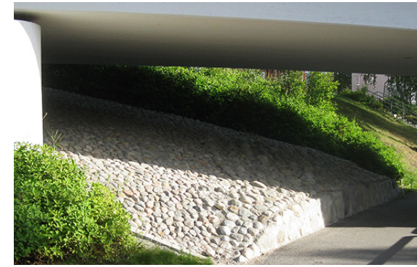
Bild 16. Slänten under bron ska stensättas med runda naturstenar. Foto: Maria Wipp
