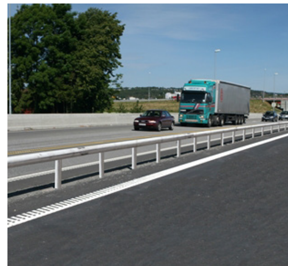
Bild 23 Exempel på ett mitträcke i rundad stålbalkstyp. Foto: Vik Ørsta
