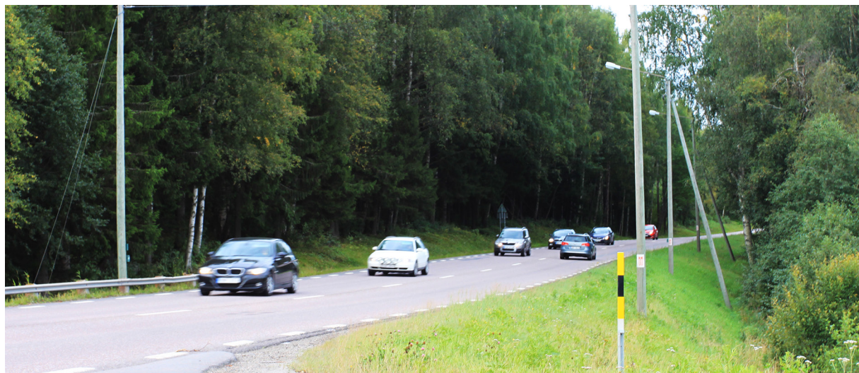
Bild 11. Väg E14 korsar en stor andel skogsmark längs den aktuella sträckan. Kuperade områden är känsliga för intrång eftersom det riskerar att bli en stor andel skärningar, bankar och stödmurar. Foto: Johan Sjölen
