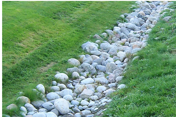
Bild 15. En vattenfåra leder ned vattnet ifrån högre delar av terrängen. Foto: Maria Wipp
