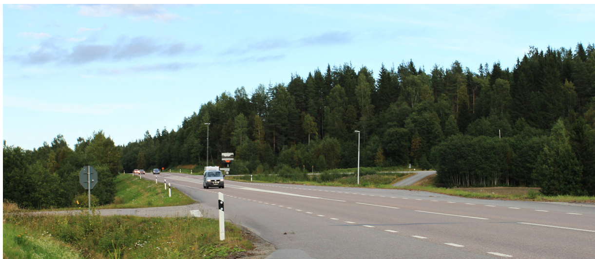
Bild 20. En ny korsning anläggs vid infarten till Blåberget. Ytorna inuti korsningen ska etableras med skog. Foto: Johan Sjöln
