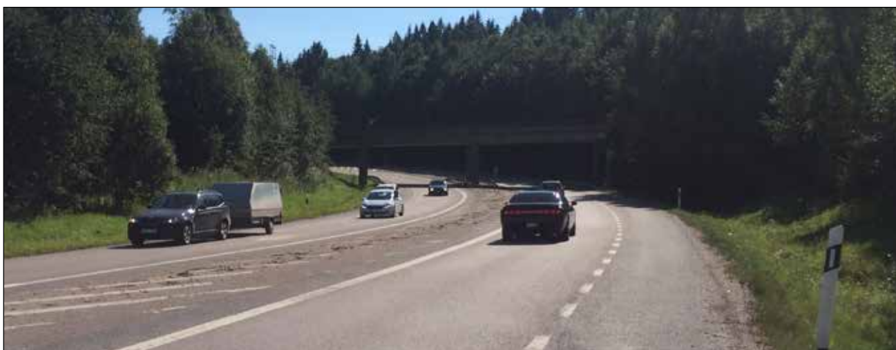
Järnvägsbro över väg 86 Timmervägen vid Nacksta
