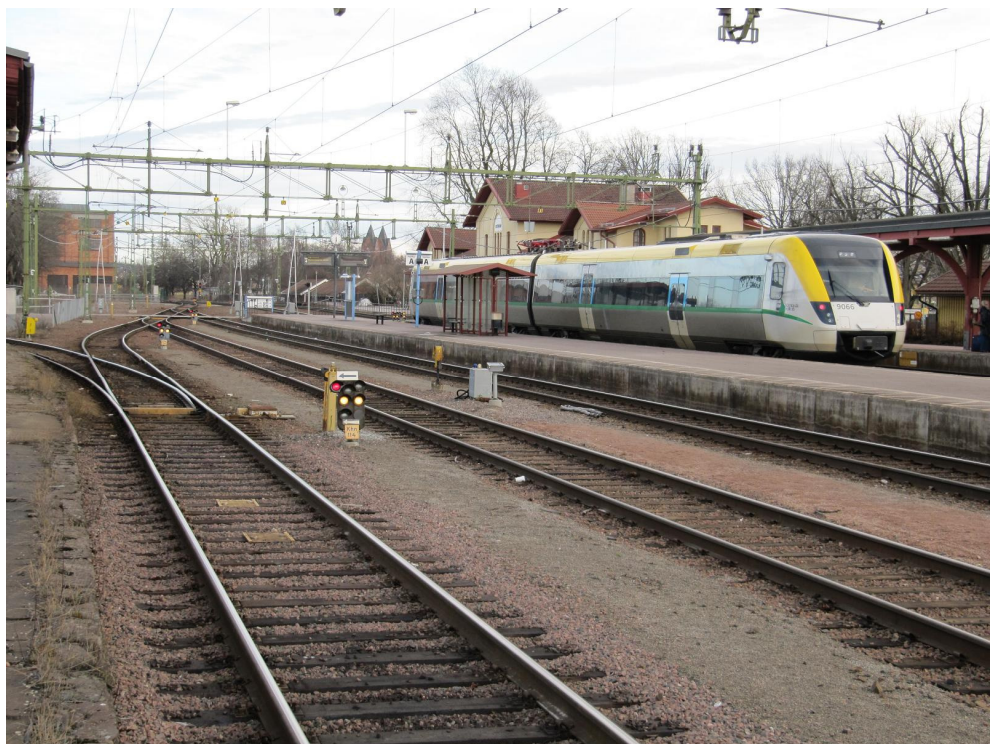
Bild 12. Mellansignal 114 i Kristinehamn, med pilskyltar av äldre modell.
