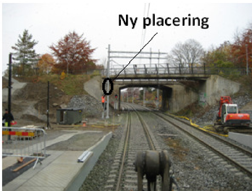
Bild 3. Mellansignal 82 i Nynäsgård. Signalen ses till höger om kontaktledningsstolpen.
