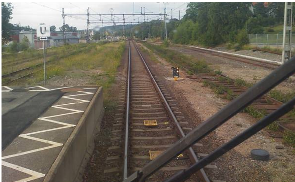
Bild 1. Signalplacering Stenungsund, huvuddvärgsignalen gäller för vänster spår men uppfattas av förare att gälla för det högra spåret.
