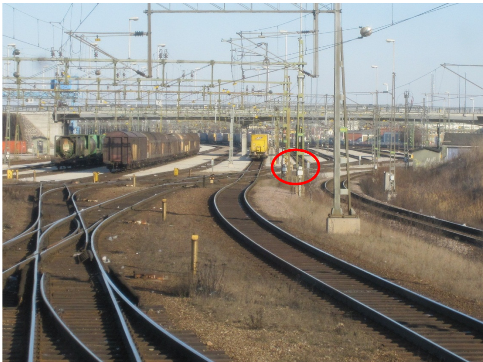
Bild 9. Växlingsdvärgsignal 382 placering markeras med den röda cirkeln. Signalen skyms helt av stolparna.
