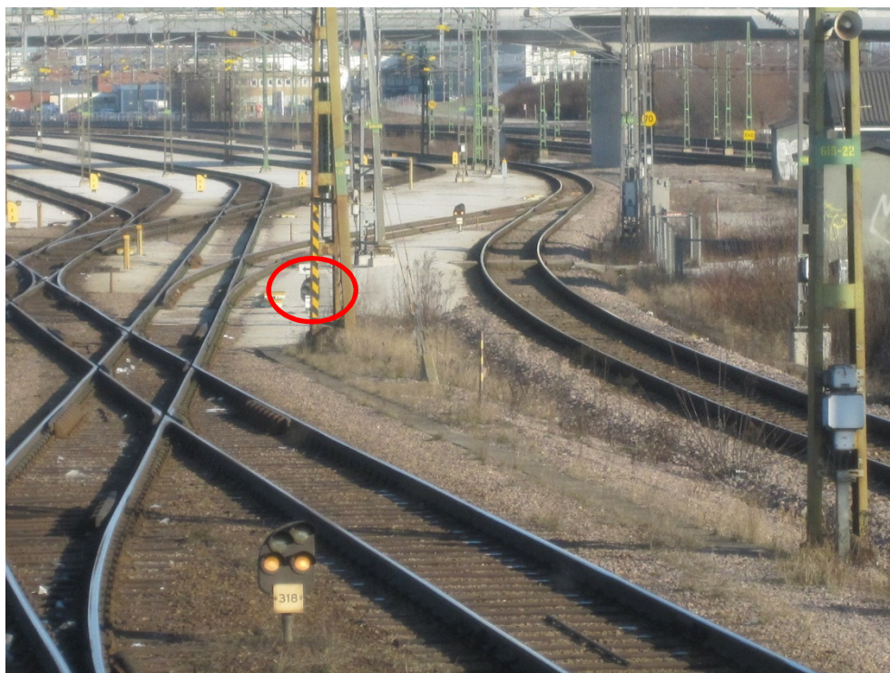
Bild 11. Växlingsdvärgsignal 382 placering markeras med den röda cirkeln. Signalen skymms åter av en stolpe. Därefter kan signalen ses klart men då är avståndet mycket kort.
