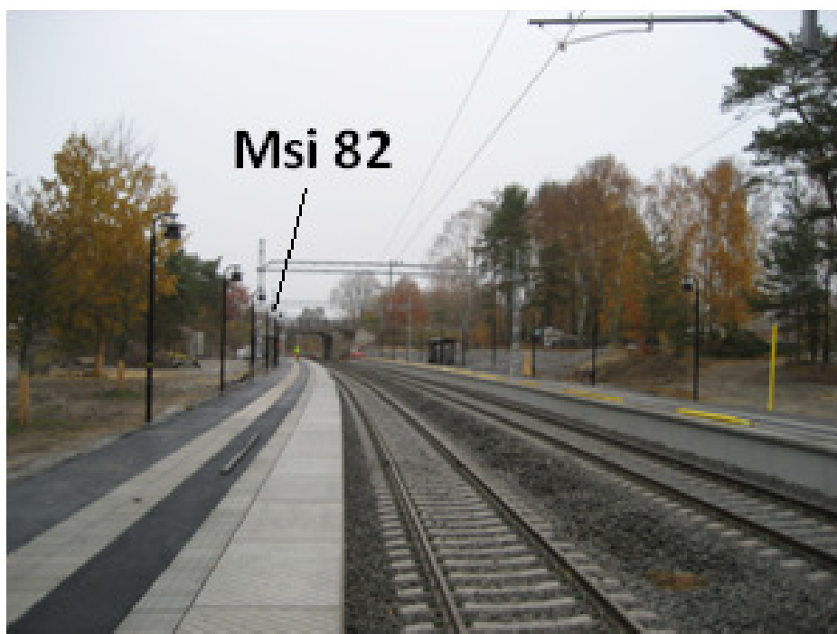
Bild 4. Mellansignal 82 i skymms av lyktstolpar på plattformen.
