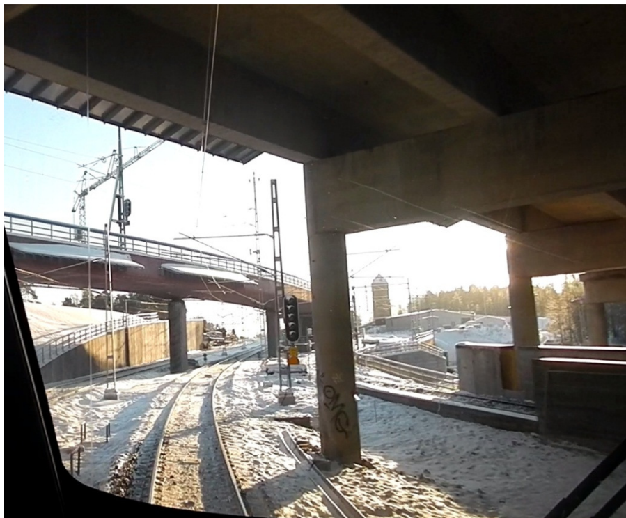
Bild 8. Mellansignal Söd 113. Siktavståndet när man närmar sig signalen är mycket kort, då den dyker upp bakom bropelaren. Ljusskenen syns sämre än normalt eftersom signalen är riktad åt höger för att i möjligaste mån ses på långt avstånd.
