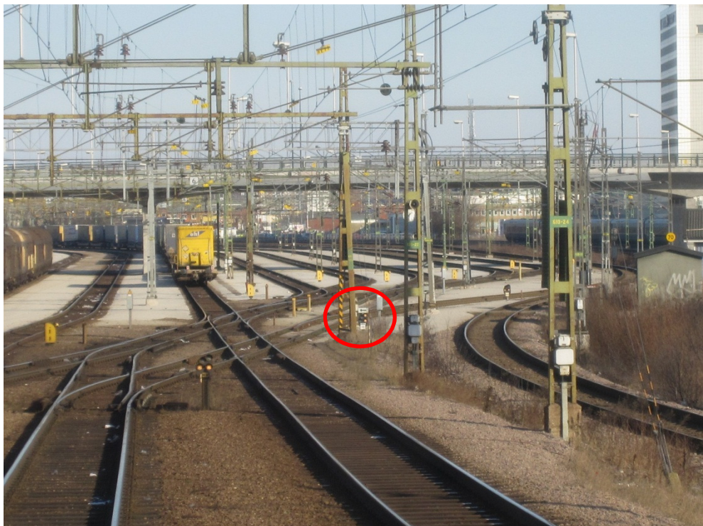
Bild 10. Växlingsdvärgsignal 382 placering markeras med den röda cirkeln. Signalen kan ses en kort stund mellan stolparna.
