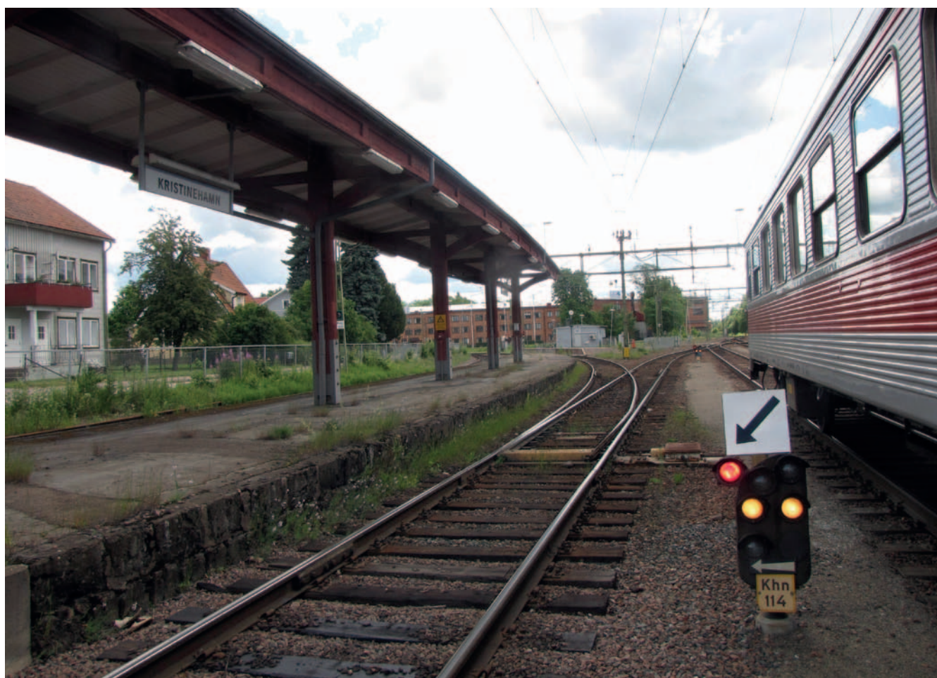
Den ena av de två små piltavlorna har bytts ut till en ny stor piltavla som är möjlig att upptäcka på håll.
