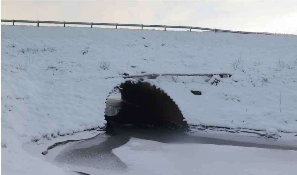
Figur 4. Väg 98 passage av Lillån, vägbank med trumma, 2015-12-04.
