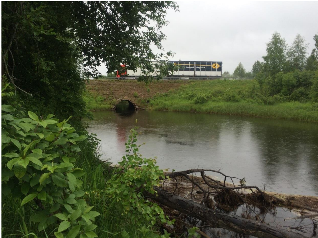
Figur 3. Väg 98 passage av Lillån, vägbank med trumma, sommaren 2017.
