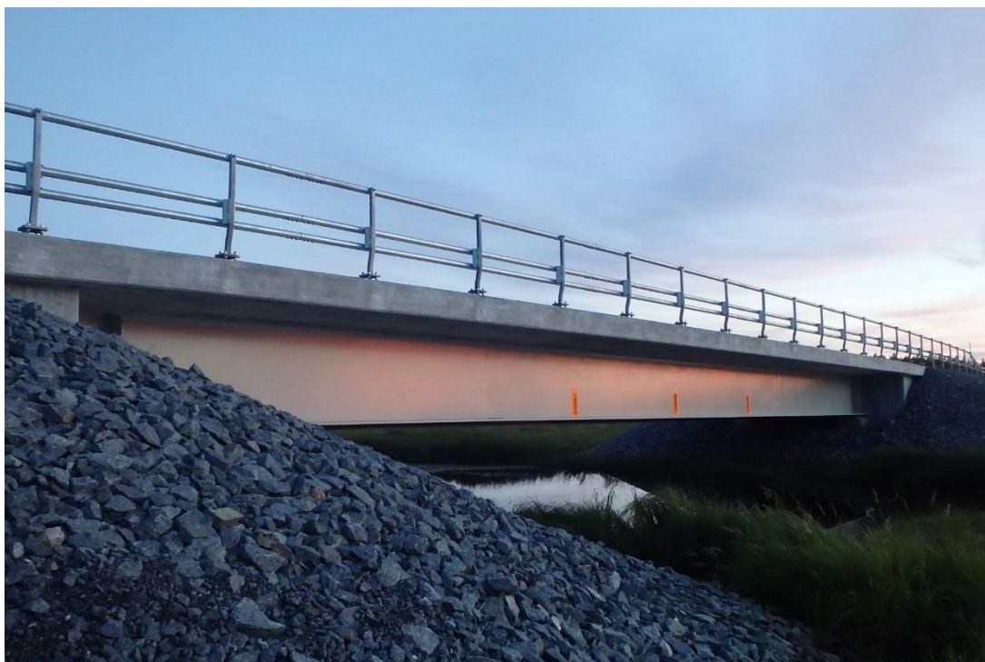
Figur 10. Exempel på stålvalsbro.
