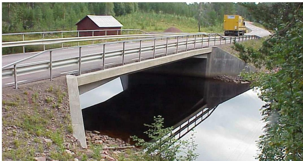
Figur 6. Exempel på plattrambro över vattendrag.
