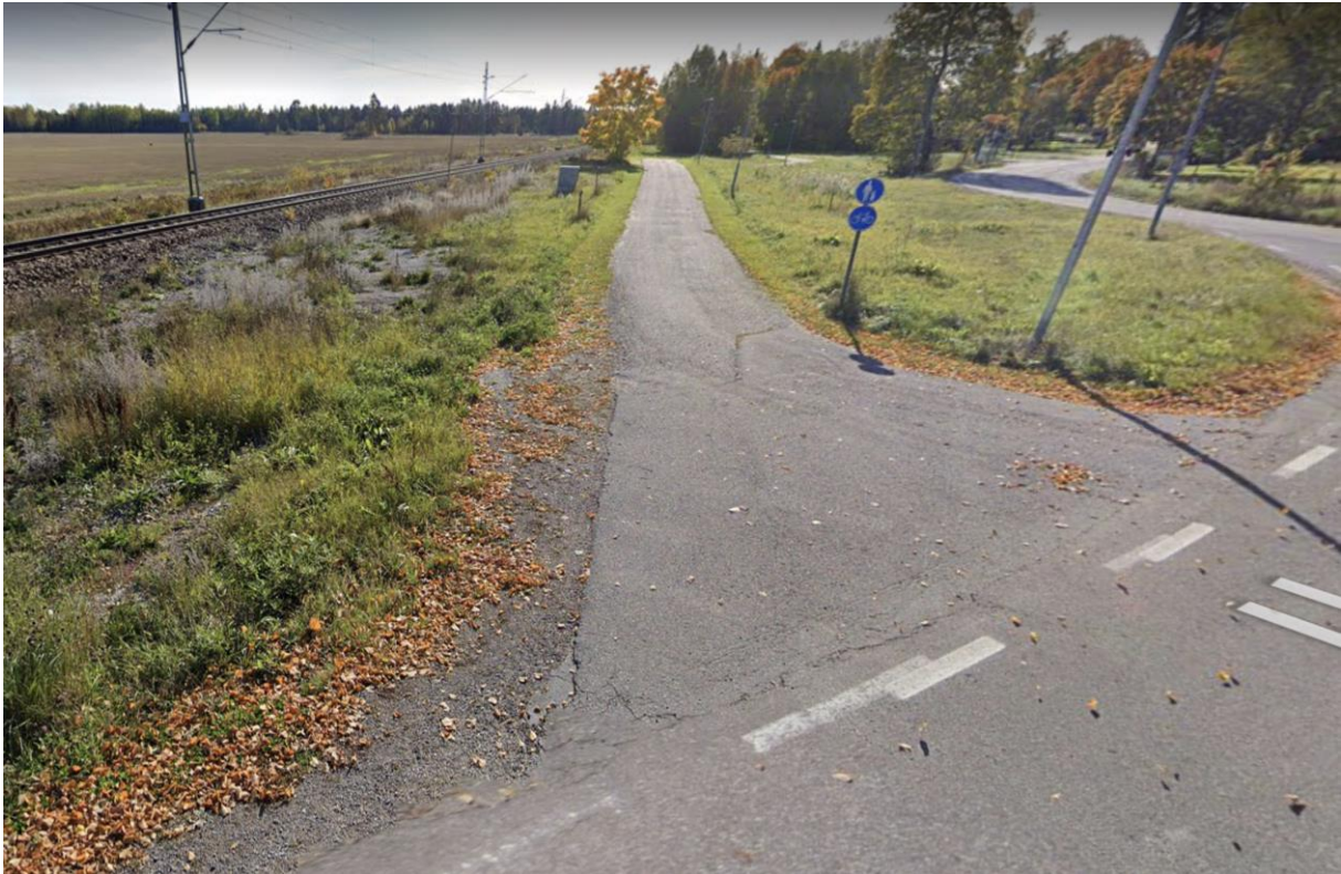
Figur 5:2 Befintlig gång- och cykelväg i Kumla kyrkby.
