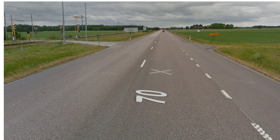
Väg 70 Tvåfältsväg mot Kumla kyrkby
