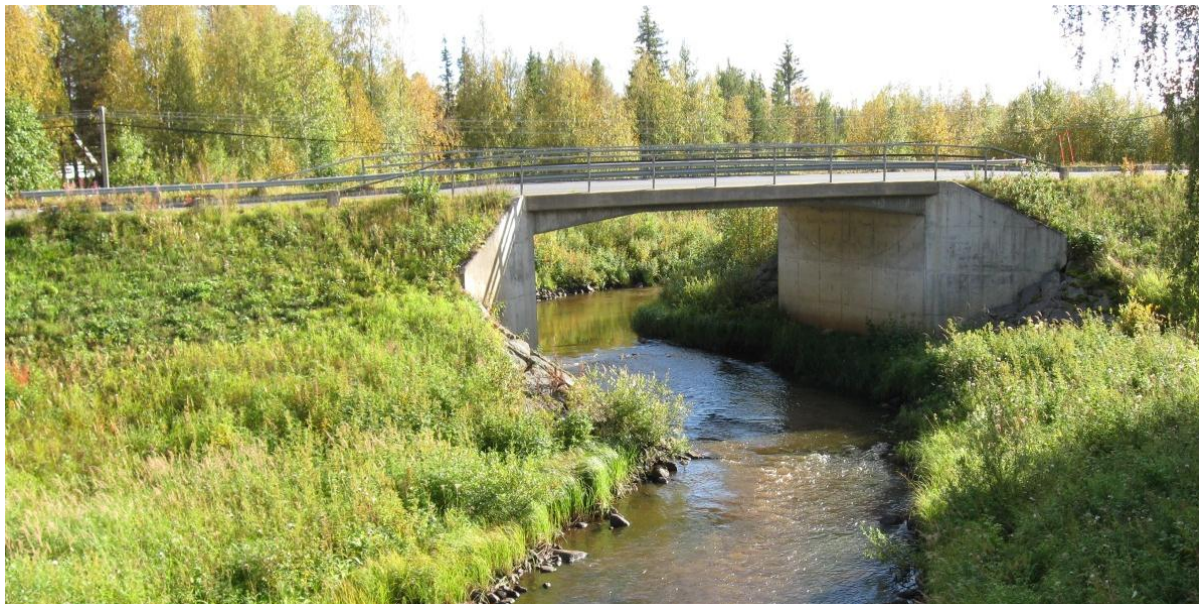
Väg 395 som här passerar över Liviöjoki väster om Juhonpieti. Foto tagit från befintlig stenvalvsbro nära utloppet till Torne älv.
