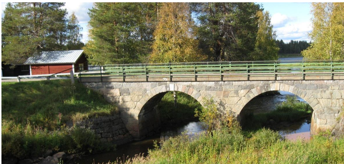
Liviöjoki med utflöde i Torne älv som passerar under stenvälsbro nära väg 395 väster om Juhonpieti. Foto tagit från en plats nära den befintliga bron över väg 395.
