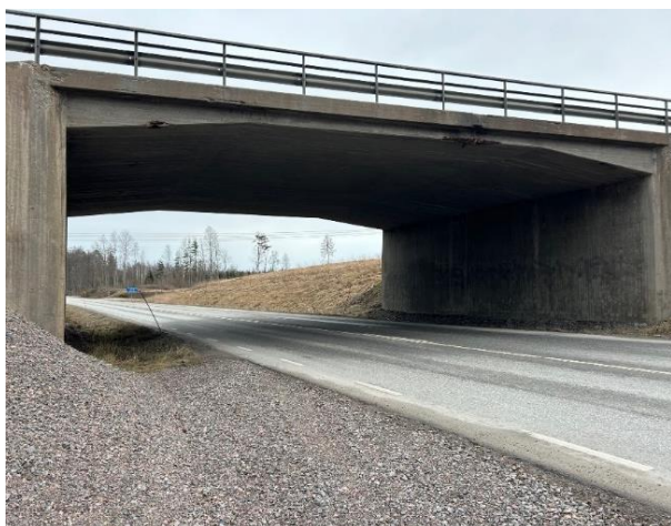
Figur 9. Bro över väg 529 vid Trafikplats Tälle (18-581-1).
