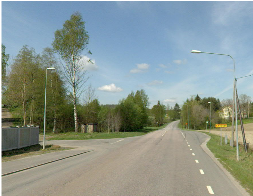
Figur 3. Belysningsstolpar anläggning Y04-86-D. Belysningscentral placerad bakom vägschild till höger. Foto vid vägplanens södra ände i norrgående riktning. Foto från bilburen laserscanning/geotracker 2019-05-22.
