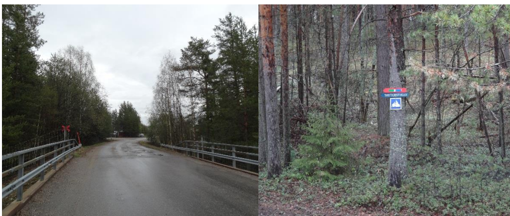
Figur 5.9-1 och 5.9-2. Befintlig skoterpassage över vägbro över väg E4 ihop med annan trafik och ledmarkering mot klubbstuga.
