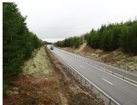
Figur 11.2-3. Utsikt från befintlig vägbro med skog på båda sidor av väg E4.
