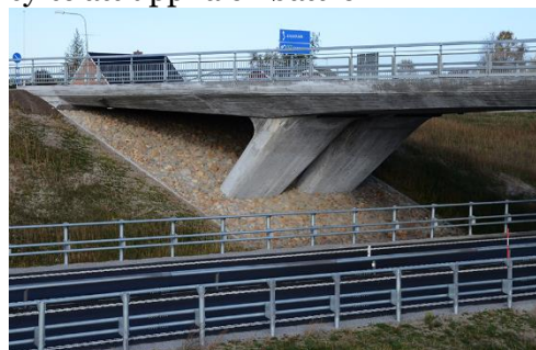
Figur 11.3-2. Exempel slänt med natursten under vägbro.
