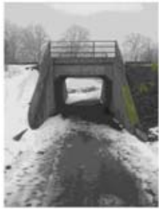
Km 225+380 Järnvägsbro över GC-väg vid Rögle Anlagd 1990. Enkelspår. Sluten plattrambro i betong. Planmått cirka 6x4 meter.
