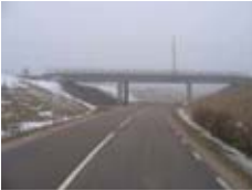
Km 225+493 Järnvägsbro över väg 1424 vid Rögle Anlagd 1990. Enkelspår. Trespanns betongbro. Vägskärmningen har permanent grundvattensänkning via dränering och pumpstation.
