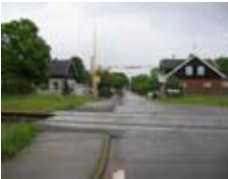
Km 230+550 Plankorsning med väg 1399, Planavägen, Kattarp
