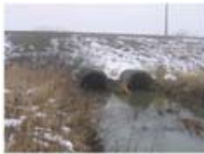
Km 228+765 Kulvert för Skavebäck vid Kattarp Två betongtrummor med diameter 2,2 meter.
