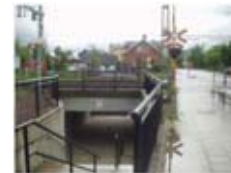
Km 234+926 Ödåkra, Järnvägsbro över gångväg Anlagd 1998. Sluten plattrambro i betong med fri brobredd 11,73 meter. Spännvidd 5,45 meter. Gångtunnelns ändrar är sammanbyggda med trappuppgångar.
