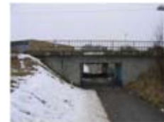
Km 234+665 Järnvägsbro över GC-väg i Ödåkra, Anlagd 1966. Öppen balkrambro med fri spännvidd 4,0 meter. Total bro längd 14,7 meter. Grundlagd på sedimentärt berg (lerskiffer/sandsten).
