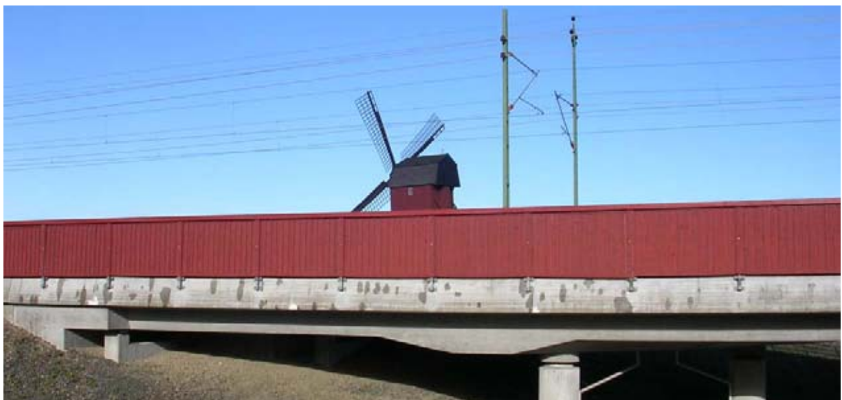
Exempel på bullerskyddsskärm som färgmässigt är anpassad till omgivande element vid Häljarp.
