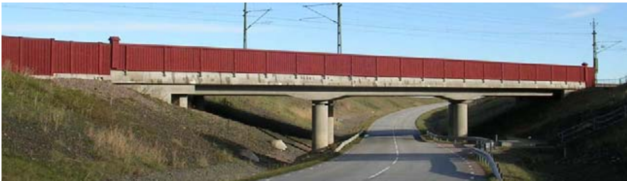
Exempelbilder järnvägsbroar från Häljarp och Dösjebro.
